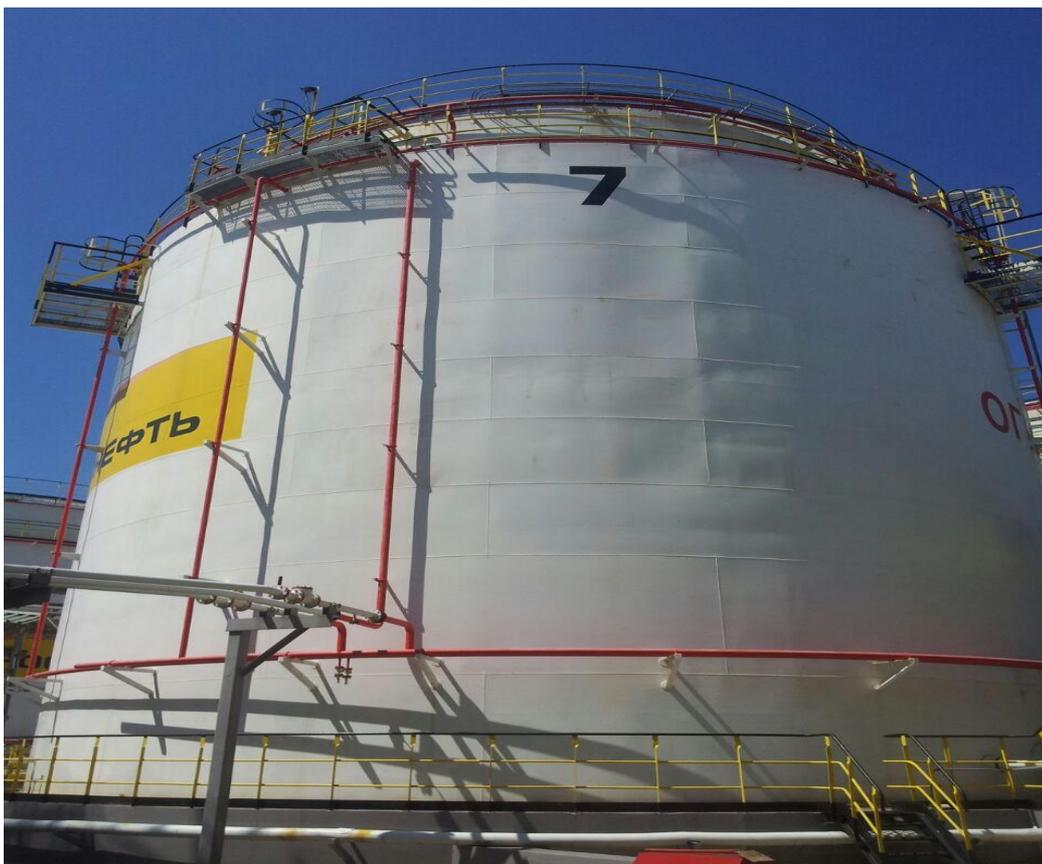
Рисунок 1 - Общий вид резервуаров с защитной стенкой РВСП-3000
