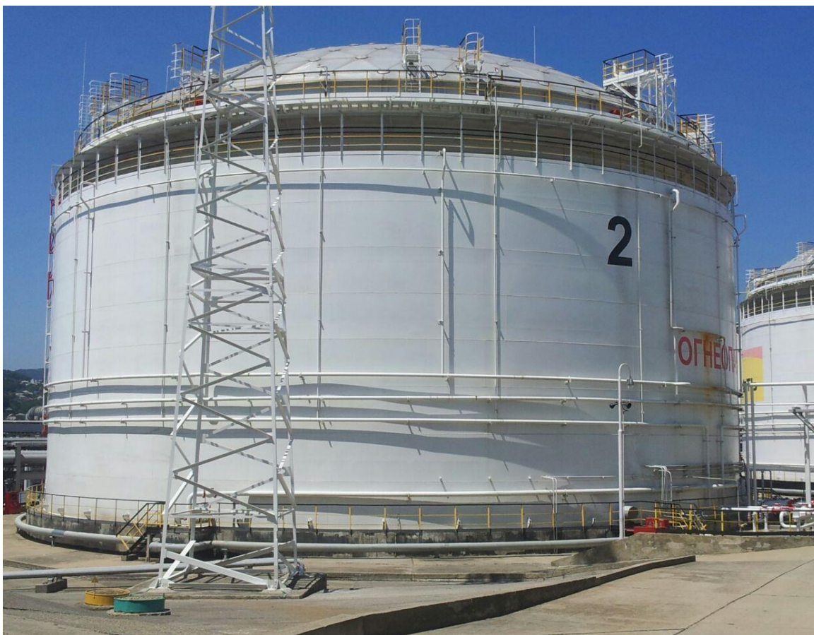
Рисунок 1 - Общий вид резервуаров с защитной стенкой РВСП-20000
