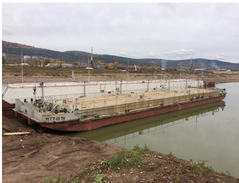
Рисунок 1 - Общий вид нефтеналивной баржи МТТ-137
