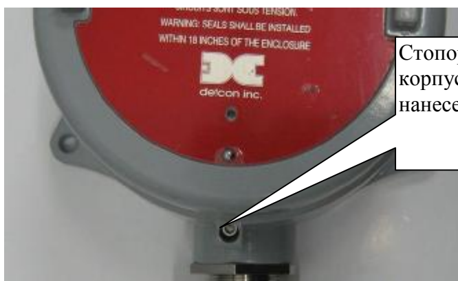
Рисунок 2 – Схема пломбировки газоанализаторов от несанкционированного доступа
