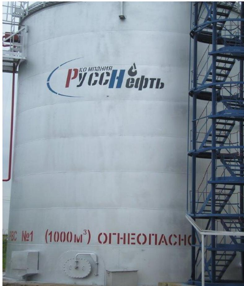
Рисунок 1 - Резервуар вертикальный стальной РВС-1000
