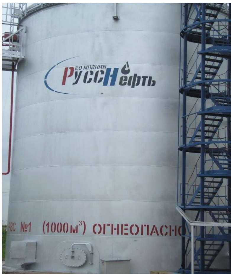
Рисунок 1 - Резервуар вертикальный стальной РВС-1000
