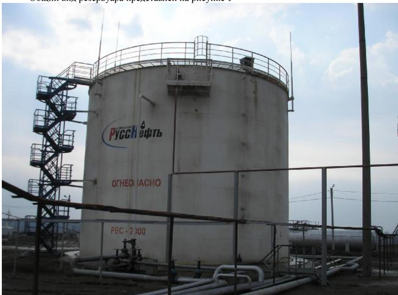
Рисунок 1 - Резервуар вертикальный стальной РВС-2000
