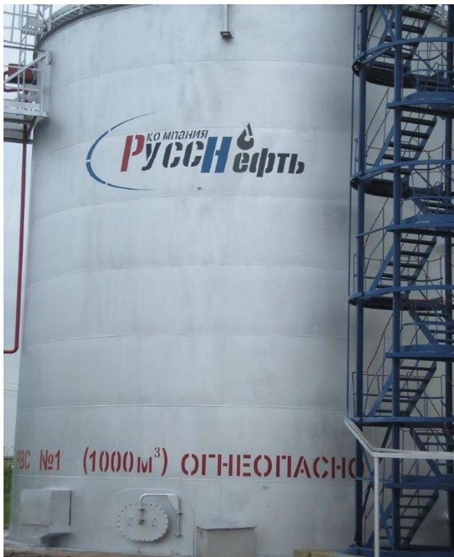
Рисунок 1 - Резервуар вертикальный стальной РВС-1000
