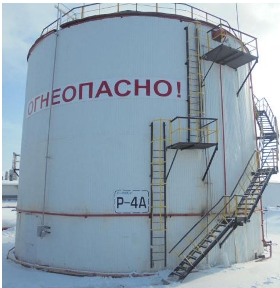
Рисунок 1 – Общий вид резервуара стального вертикального цилиндрического РВС-2000
