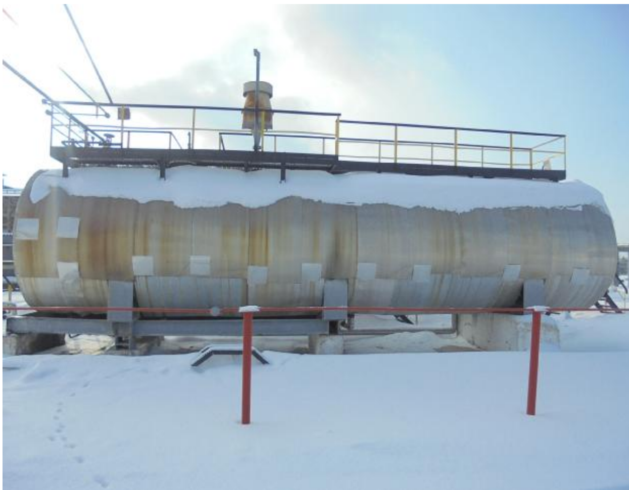
Рисунок 1 – Общий вид резервуара стального горизонтального цилиндрического РГС-100
