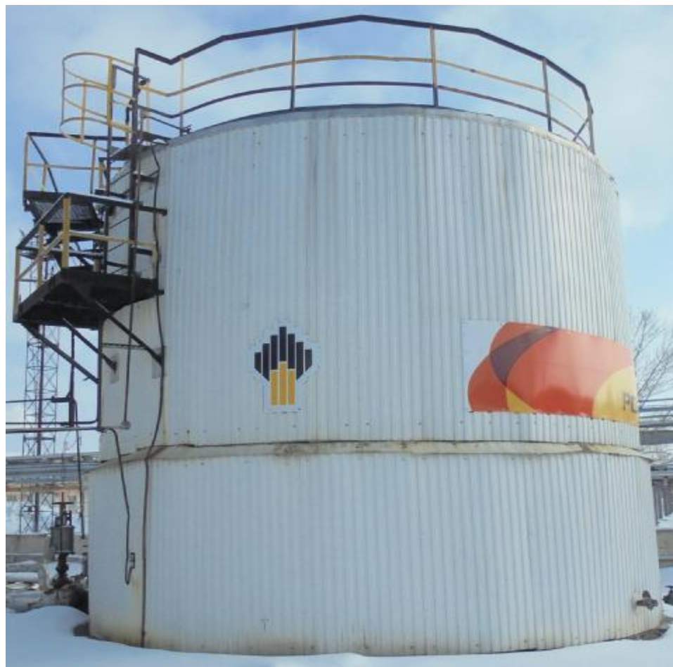
Рисунок 1 – Общий вид резервуара стального вертикального цилиндрического РВС-200
