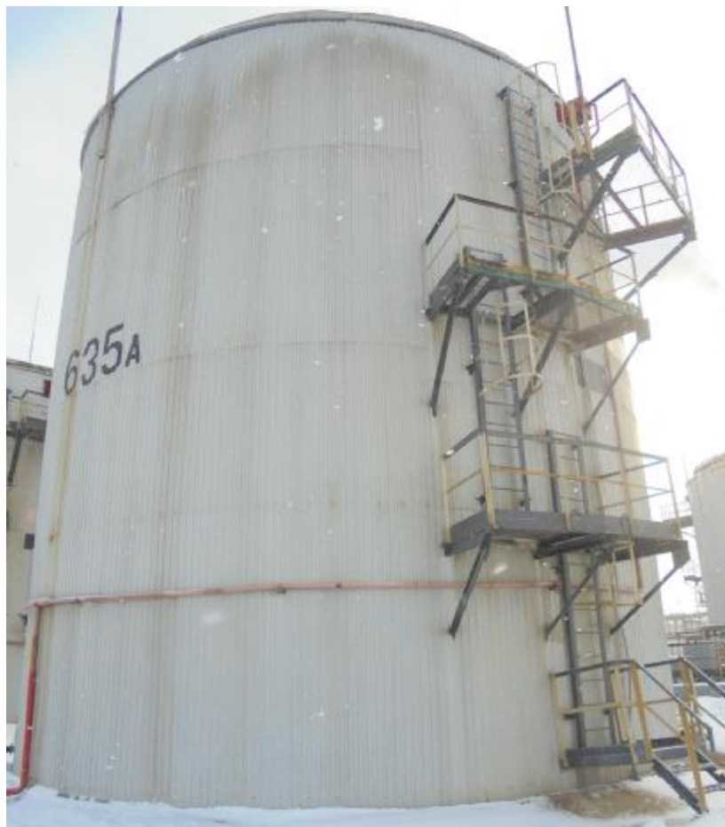
Рисунок 1 – Общий вид резервуара стального вертикального цилиндрического РВС-1000
