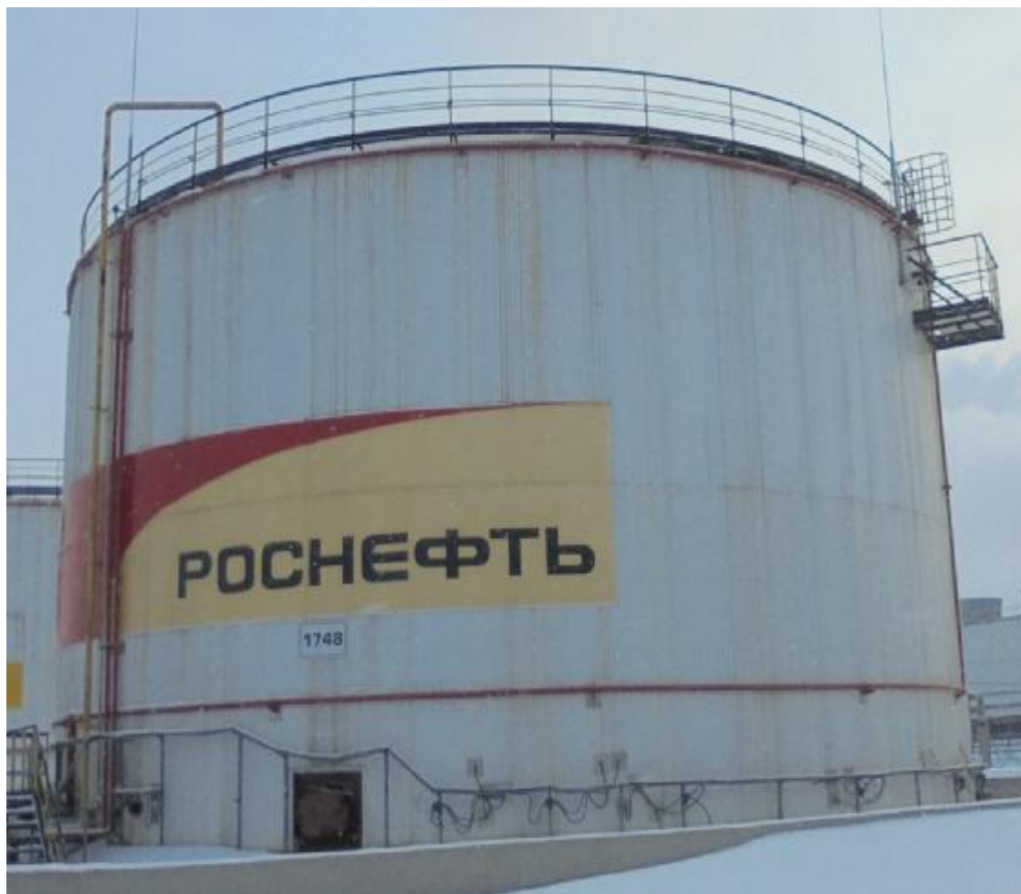
Рисунок 2 – Общий вид резервуара стального вертикального цилиндрического РВС-5000
