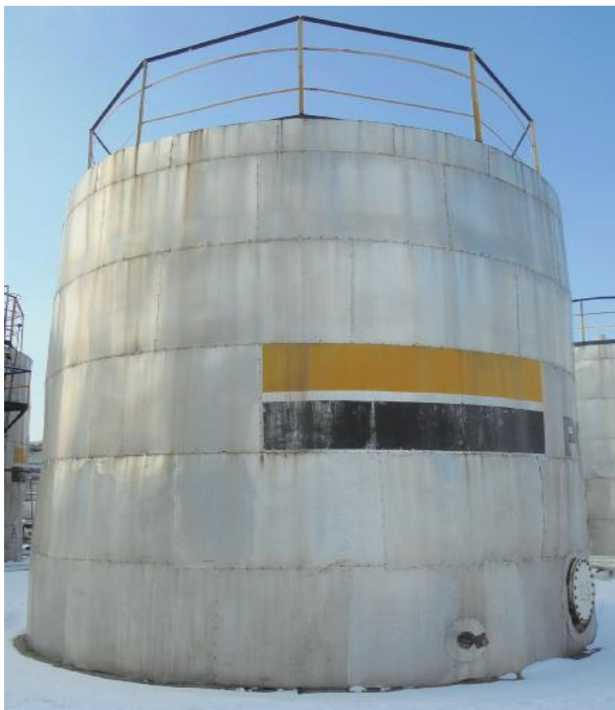
Рисунок 1 – Общий вид резервуара стального вертикального цилиндрического РВС-200
