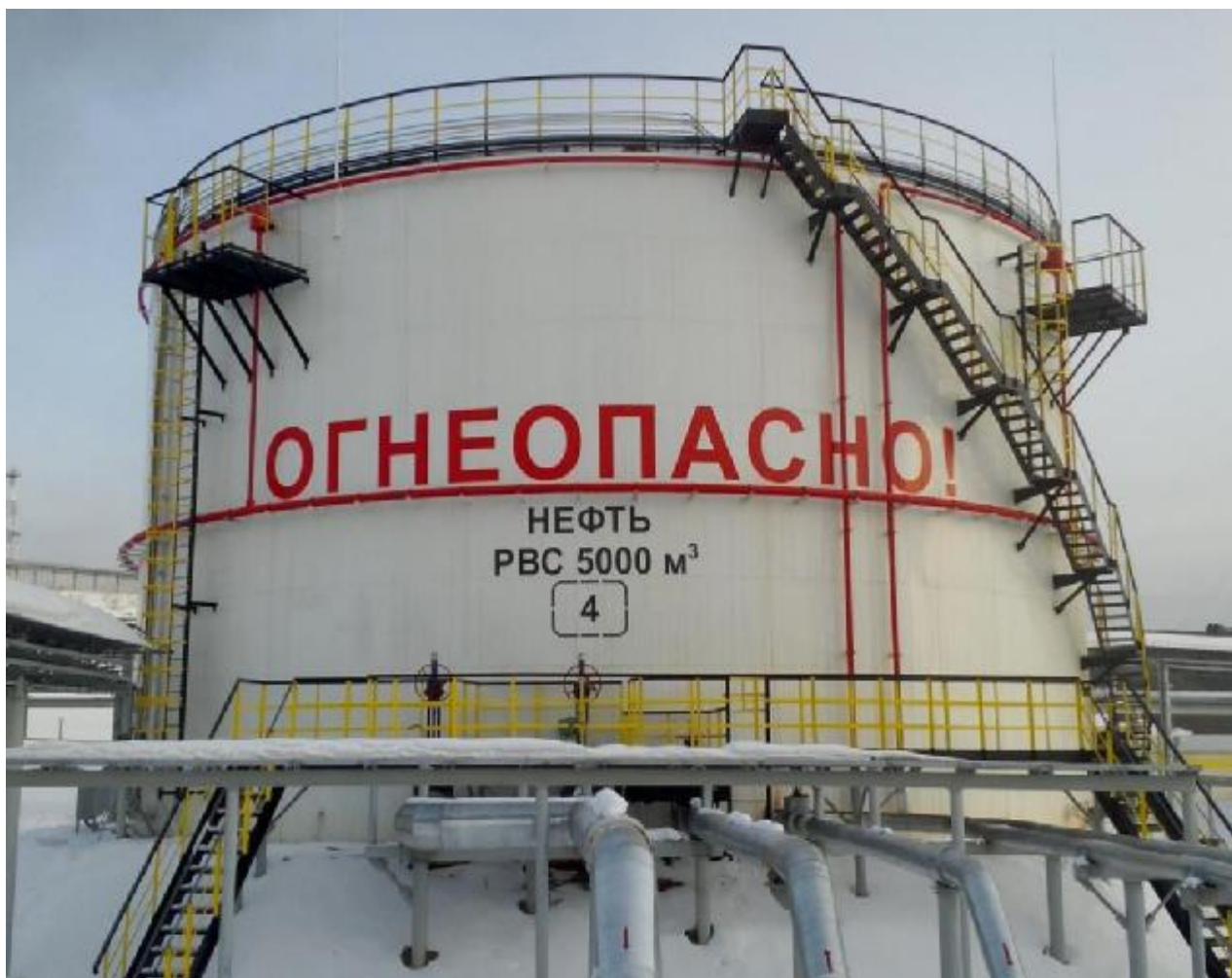
Рисунок 1 – Общий вид резервуара стального вертикального цилиндрического РВС-5000
