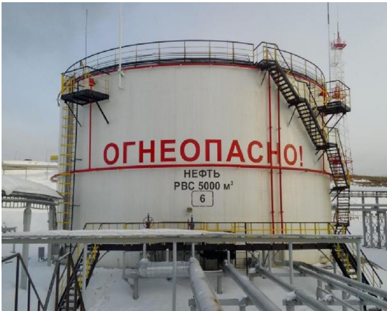
Рисунок 1 – Общий вид резервуара стального вертикального цилиндрического РВС-5000
