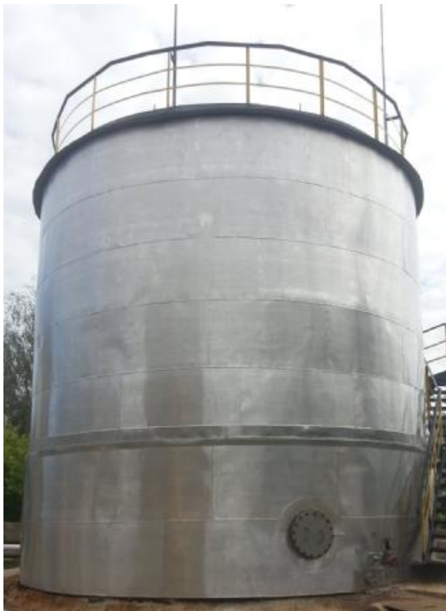
Рисунок 3 - Общий вид резервуара стального вертикального цилиндрического РВС-300
