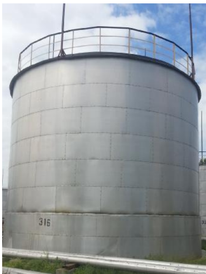
Рисунок 5 - Общий вид резервуара стального вертикального цилиндрического РВС-700
