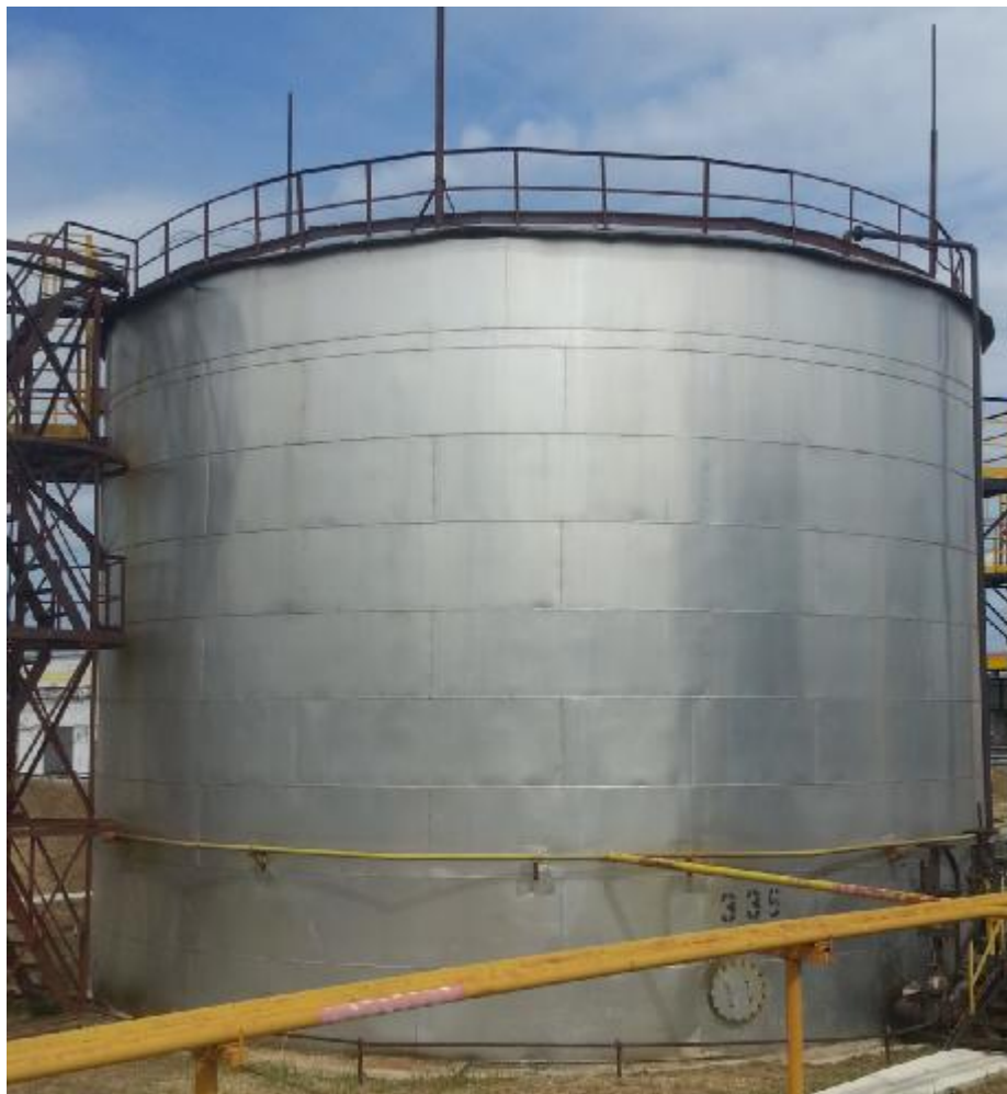
Рисунок 6 - Общий вид резервуара стального вертикального цилиндрического РВС-1000
