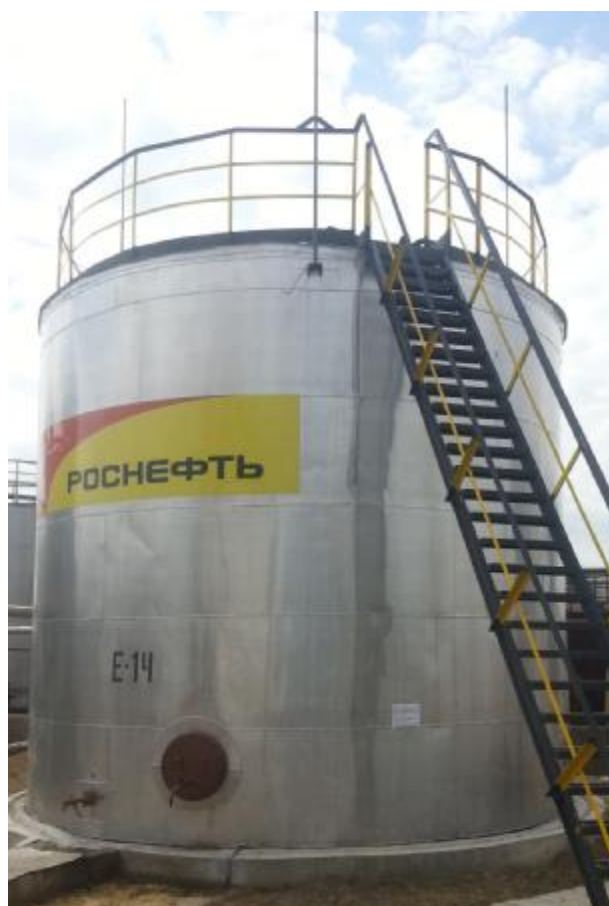
Рисунок 2 - Общий вид резервуара стального вертикального цилиндрического РВС-200
