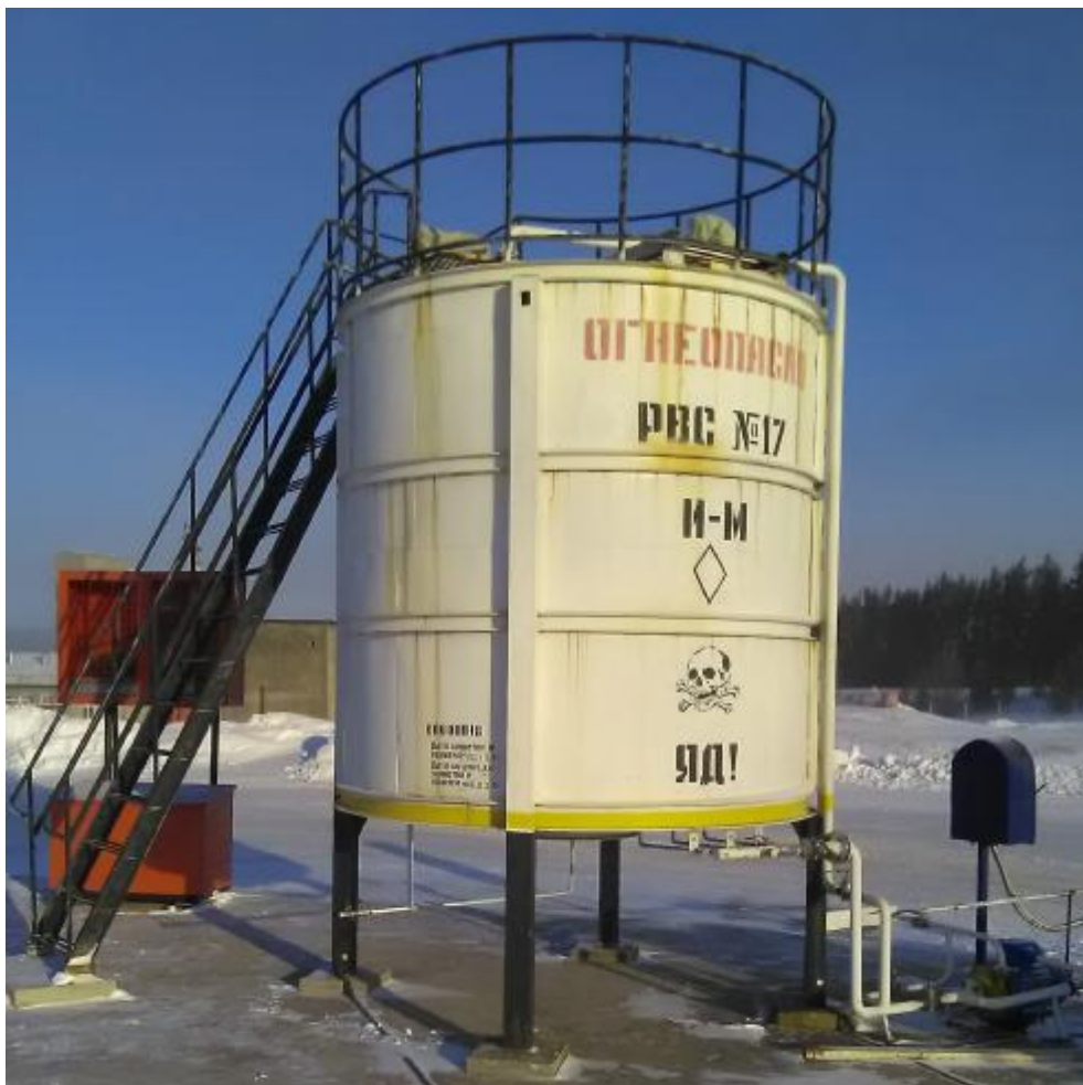
Рисунок 1 - Общий вид резервуара стального вертикального цилиндрического РВС-12
