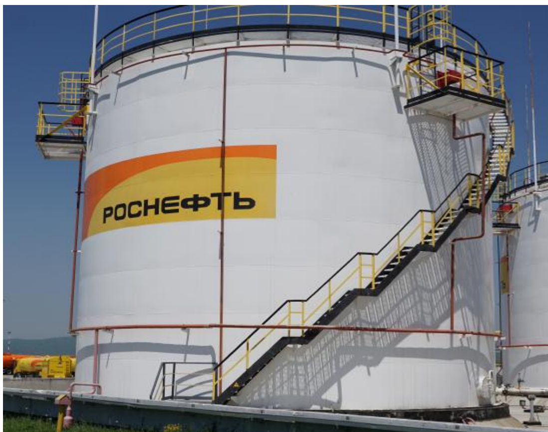
Рисунок 1 - Общий вид резервуара стального вертикального цилиндрического РВС-2000
