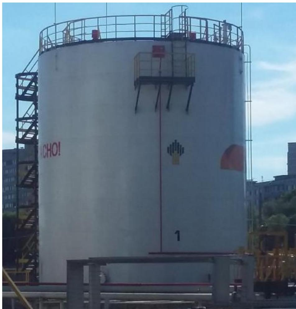
Рисунок 1 - Общий вид резервуара стального вертикального цилиндрического РВС-1000
