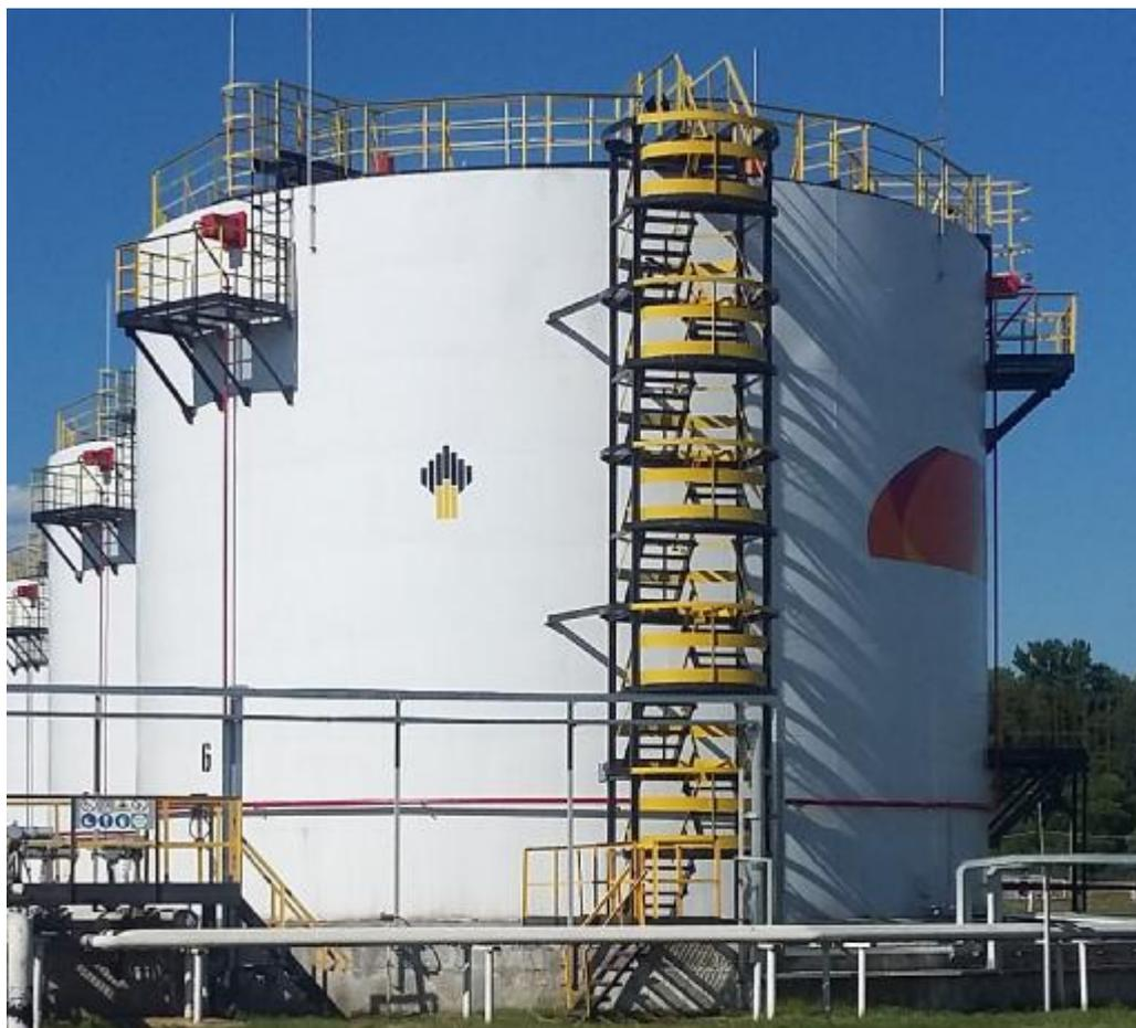
Рисунок 2 - Общий вид резервуара стального вертикального цилиндрического РВС-2000
