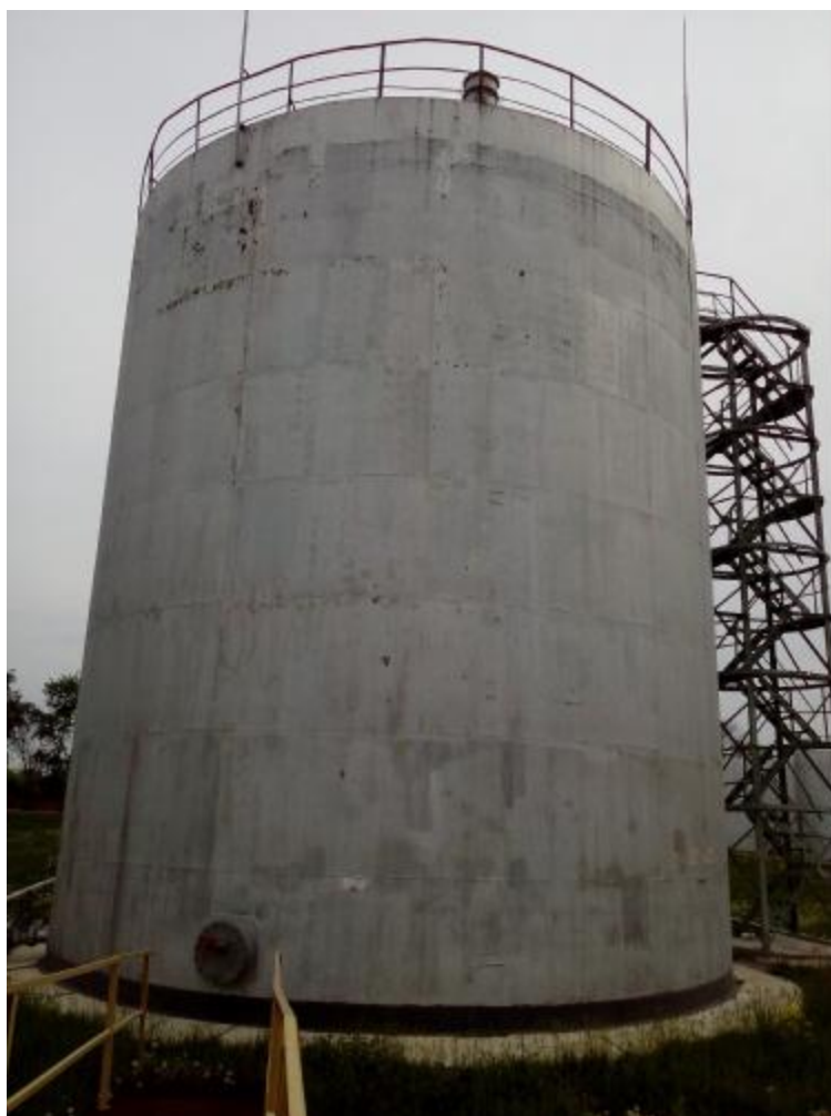
Рисунок 1 - Общий вид резервуара стального вертикального цилиндрического РВС-1000
