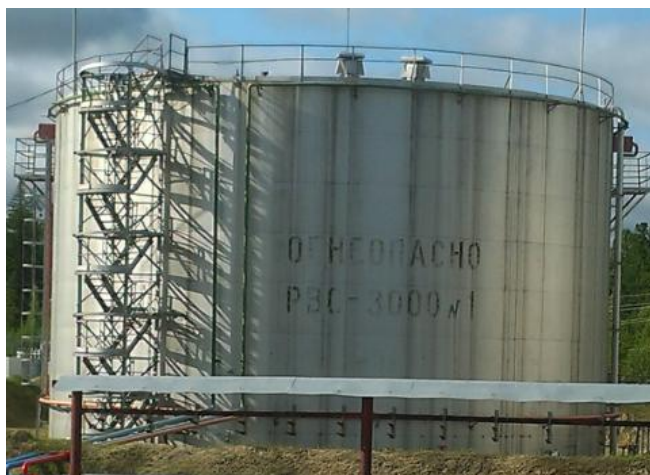
Рисунок 1 - Общий вид резервуара
