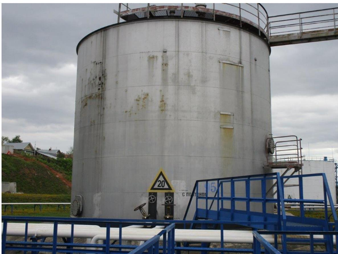
Рисунок 3 – Общий вид резервуара вертикального стального цилиндрического РВСП-700
