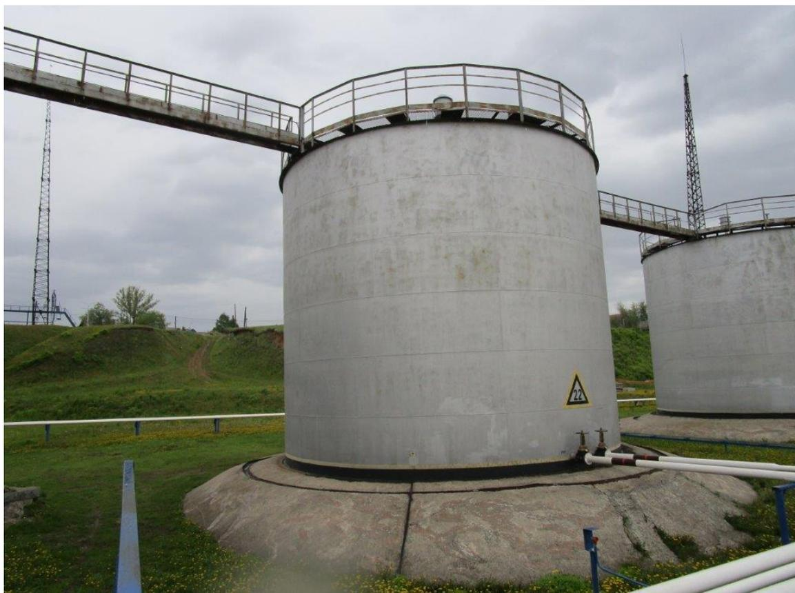
Рисунок 2 – Общий вид резервуара вертикального стального цилиндрического РВС-700
