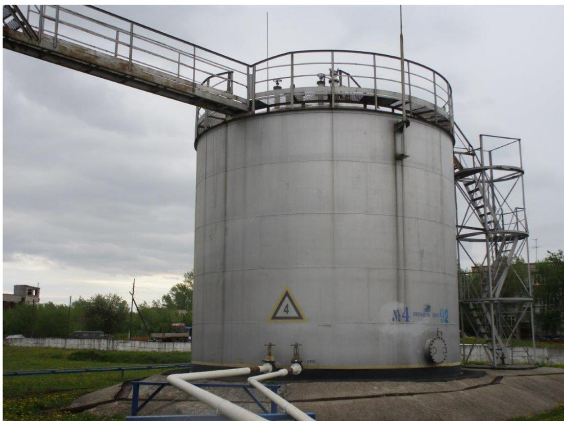
Рисунок 1 – Общий вид резервуара вертикального стального цилиндрического РВС-400
