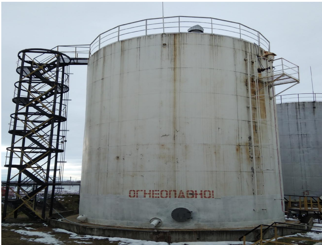
Рисунок 1 - Общий вид резервуара стального вертикального цилиндрического РВСП-1000
