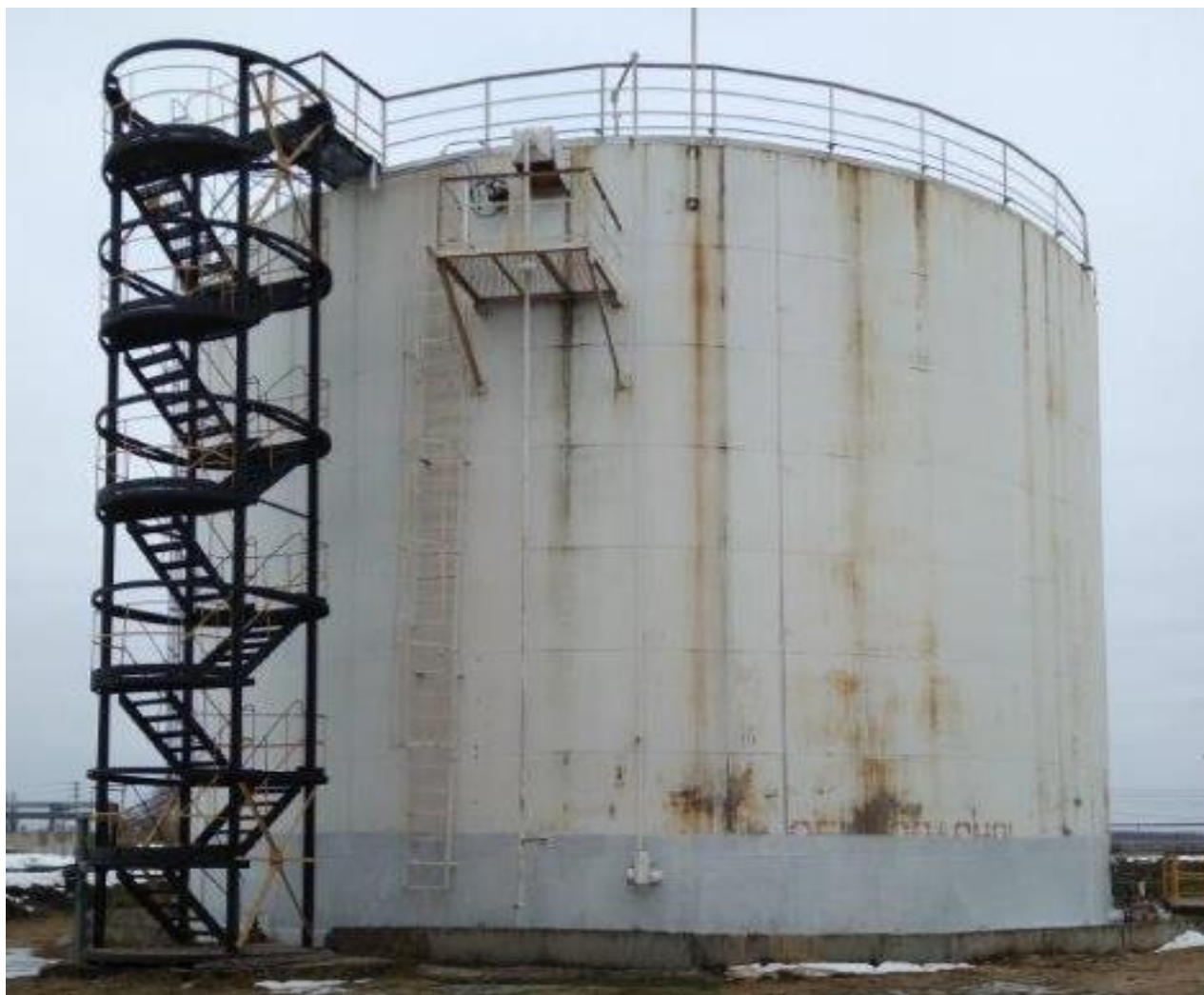
Рисунок 2 - Общий вид резервуара стального вертикального цилиндрического РВС-2000
