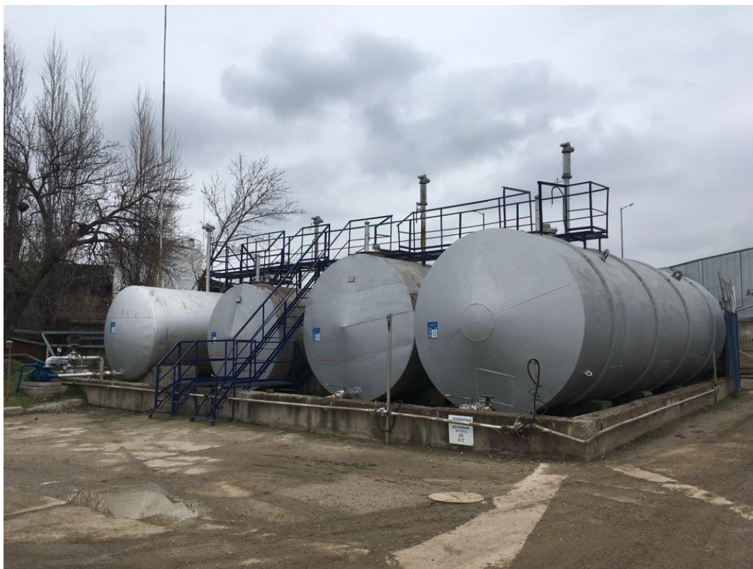
Рисунок 1 - Общий вид резервуаров горизонтальных стальных цилиндрических РГС-50, РГС-70 и РГС-80
