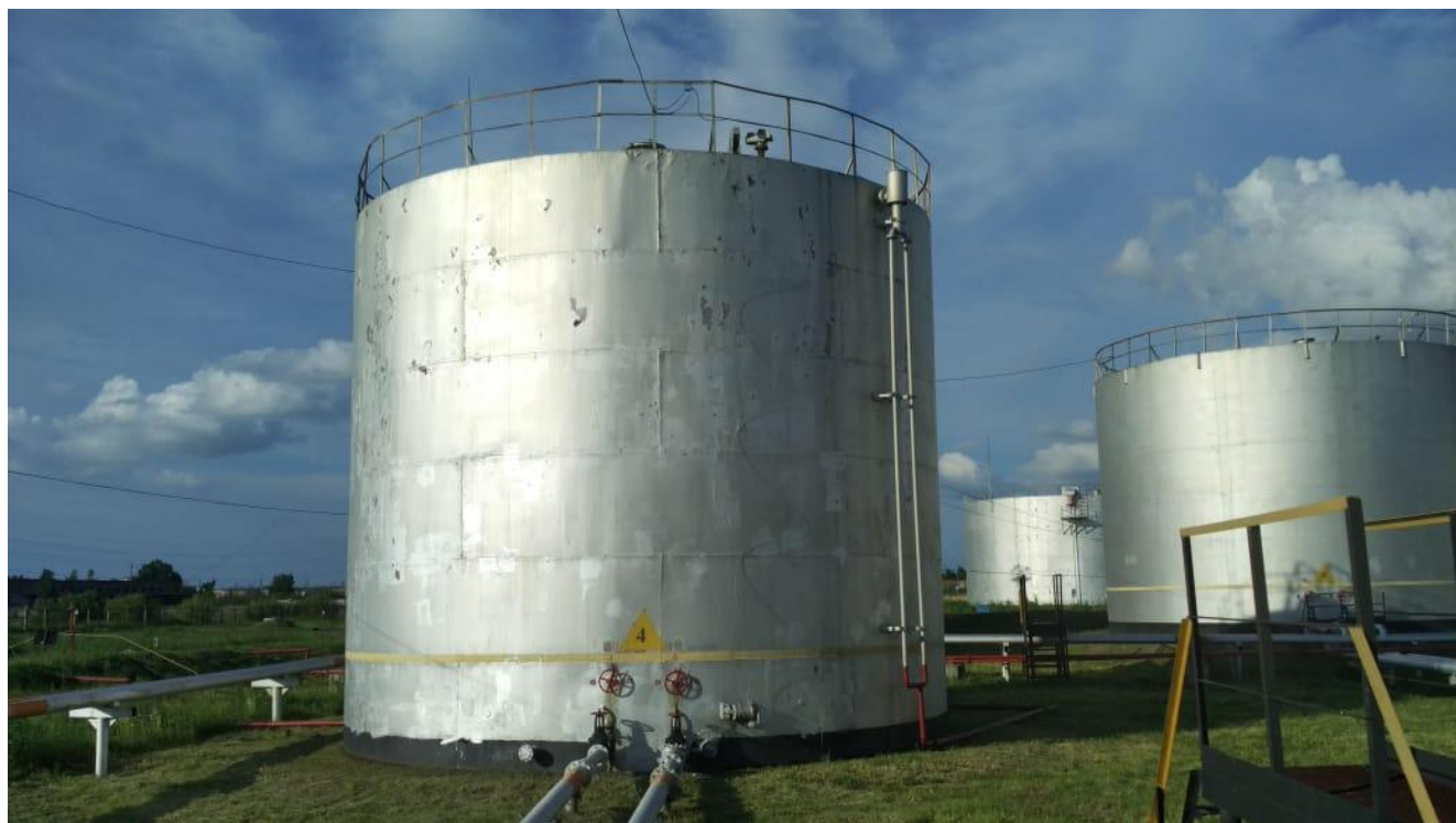
Рисунок 1 - Общий вид резервуара вертикального стального цилиндрического РВС-700
