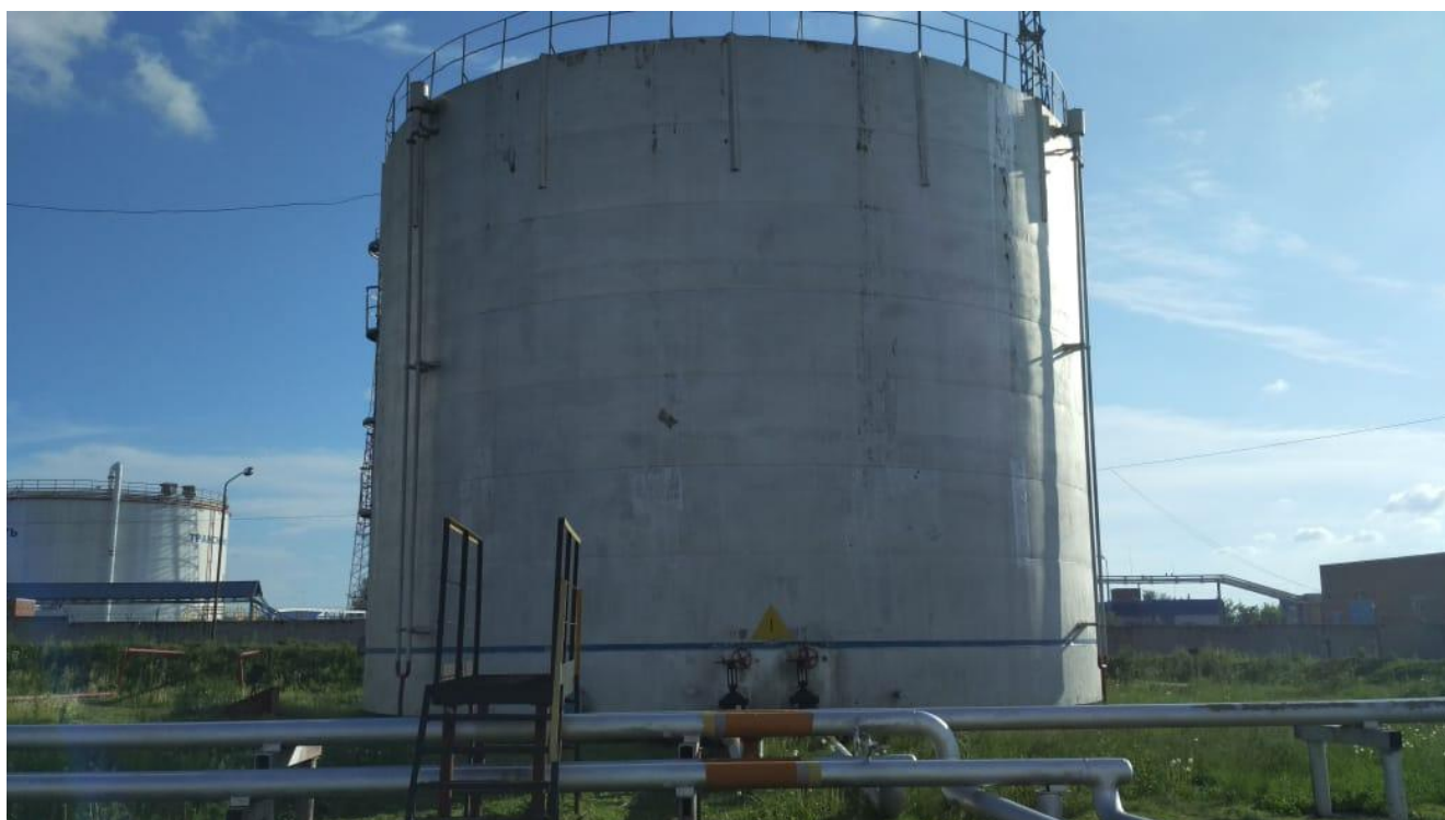
Рисунок 3 - Общий вид резервуара вертикального стального цилиндрического РВС-2000
