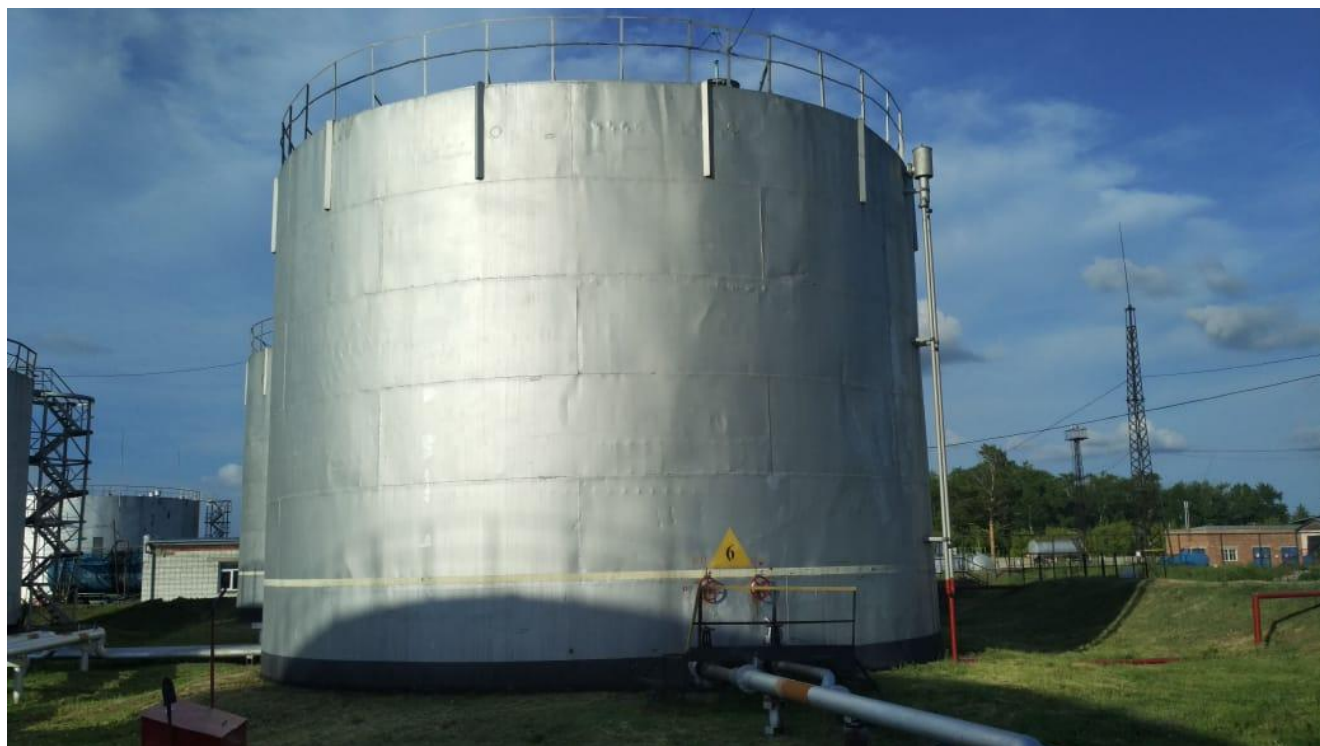
Рисунок 2 - Общий вид резервуара вертикального стального цилиндрического РВС-1000
