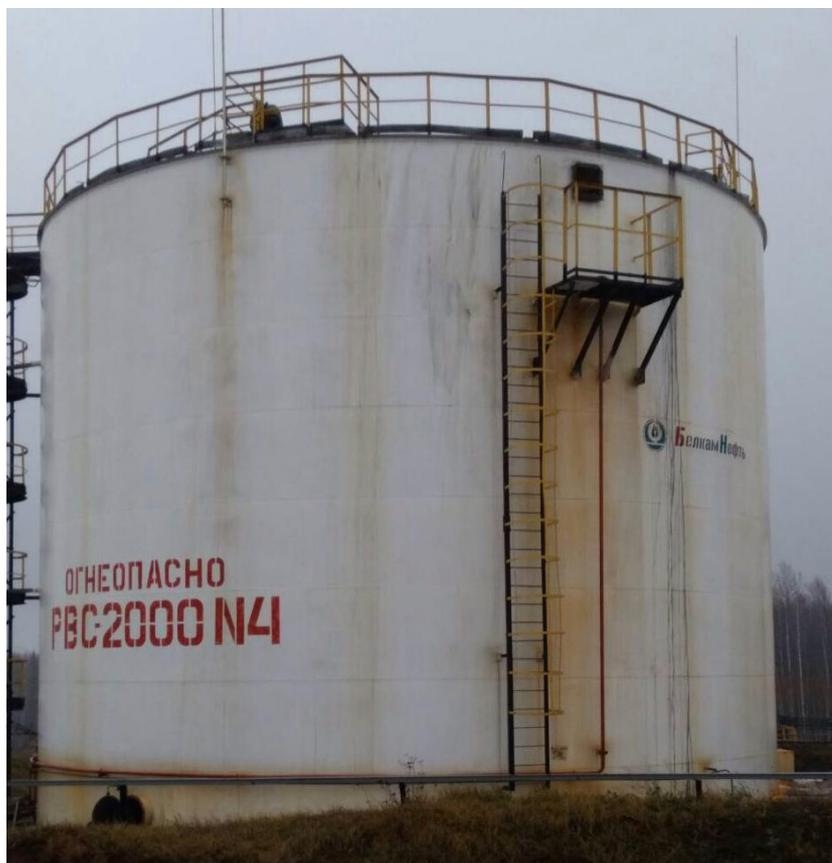
Рисунок 1 - Общий вид резервуара РВС-2000
