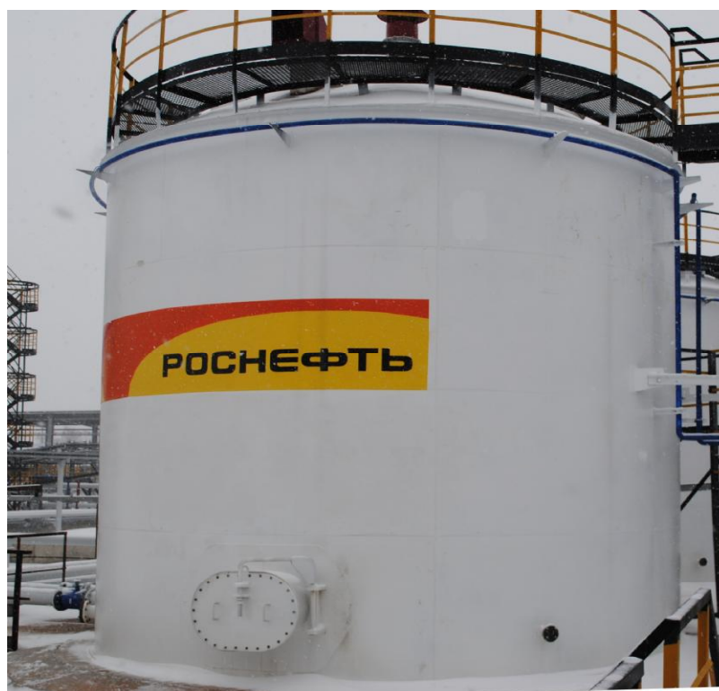
Рисунок 1 - Общий вид резервуара стального вертикального цилиндрического РВСП-200
