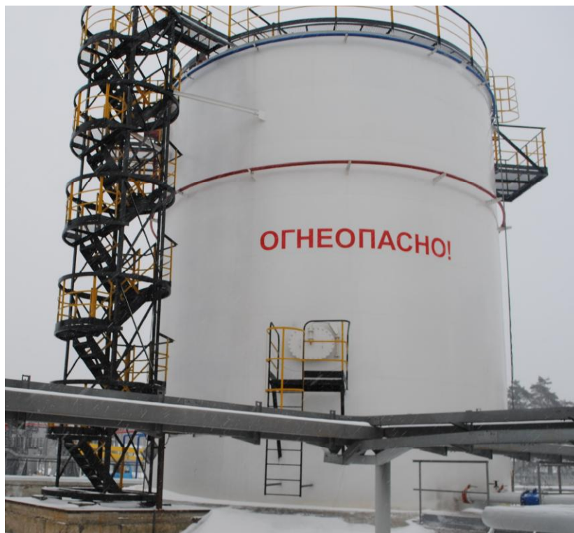
Рисунок 2 - Общий вид резервуара стального вертикального цилиндрического РВСП-1000
