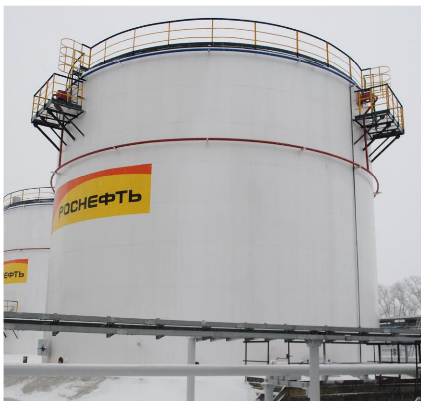
Рисунок 3 - Общий вид резервуара стального вертикального цилиндрического РВС-2000, РВСП-2000
