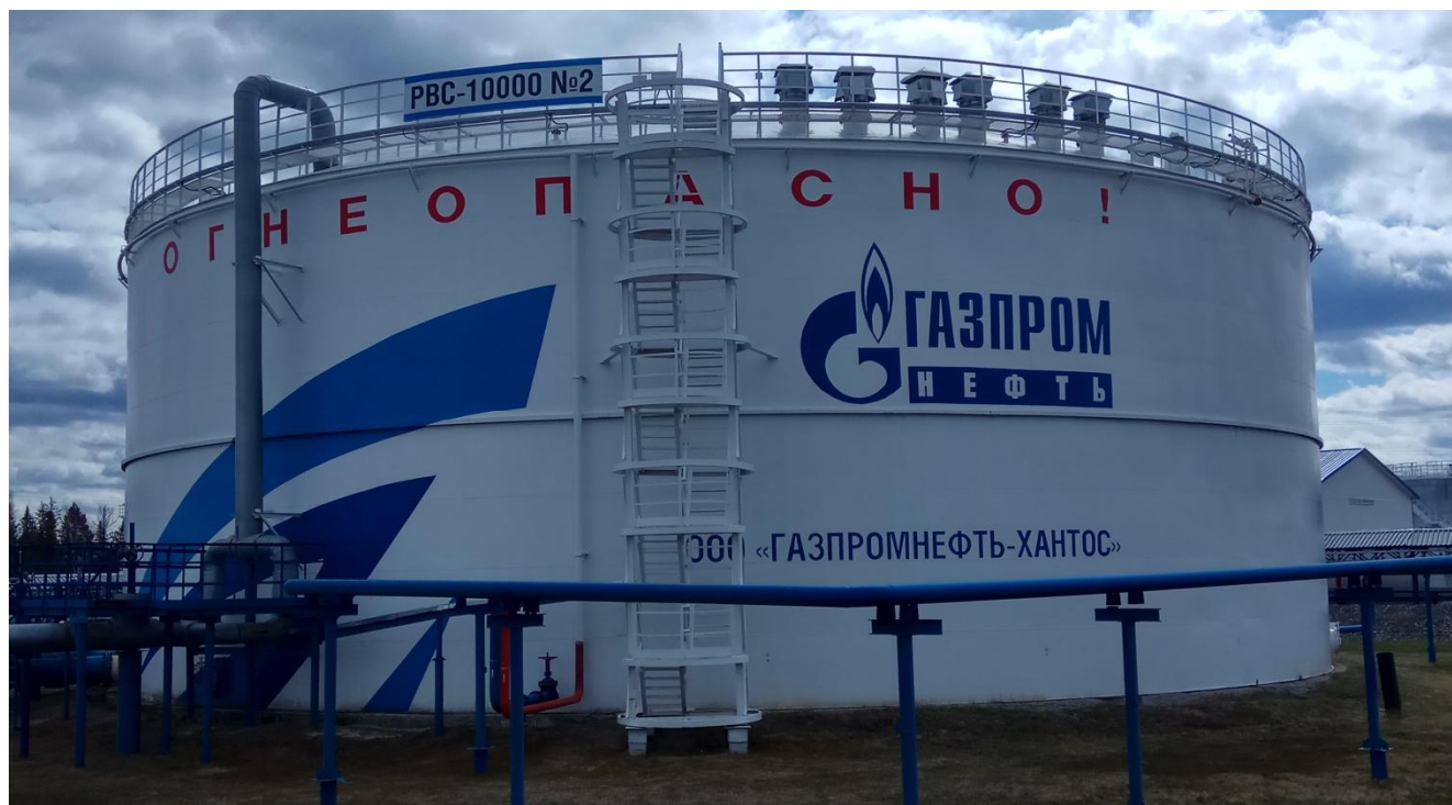
Рисунок 1 - Общий вид резервуара РВС-10000
