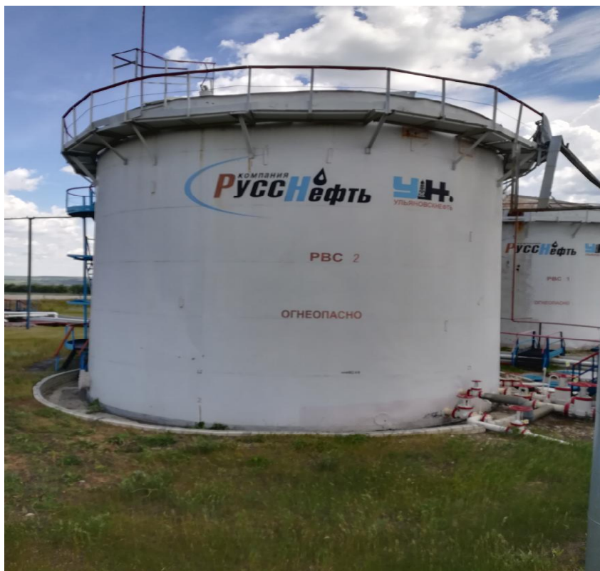
Рисунок 3 - Общий вид резервуара вертикального стального цилиндрического РВС-700 зав. № 2
