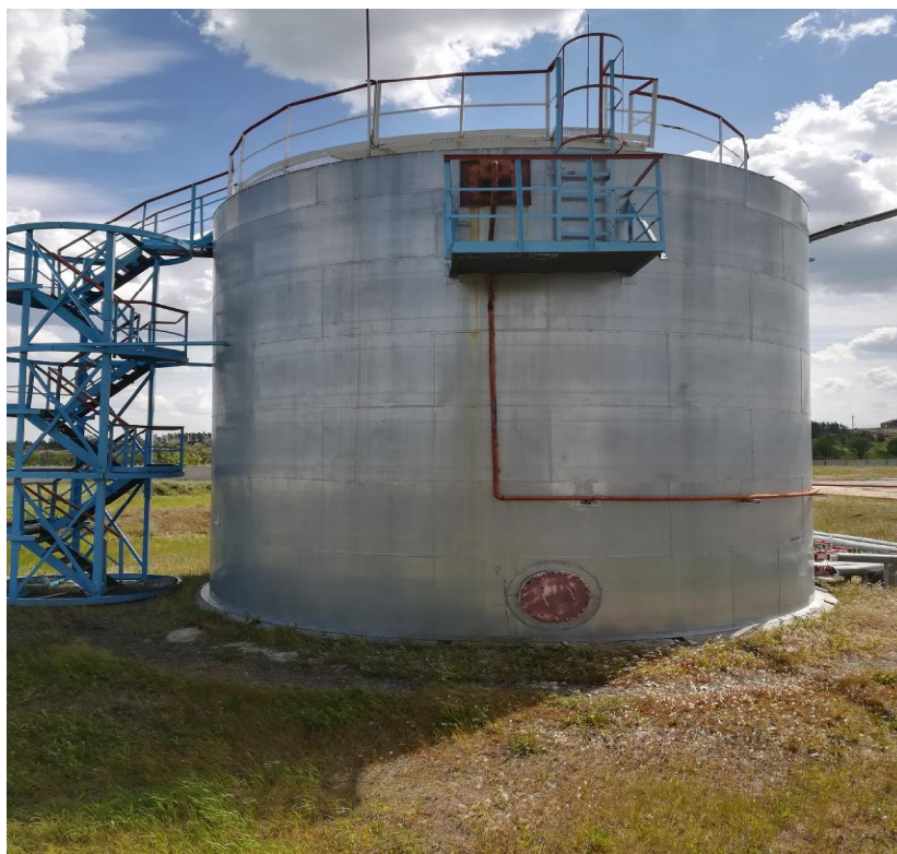
Рисунок 1 - Общий вид резервуара вертикального стального цилиндрического РВС-400 зав. № 3
