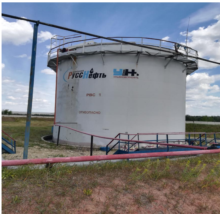
Рисунок 2 - Общий вид резервуара вертикального стального цилиндрического РВС-700 зав. № 1
