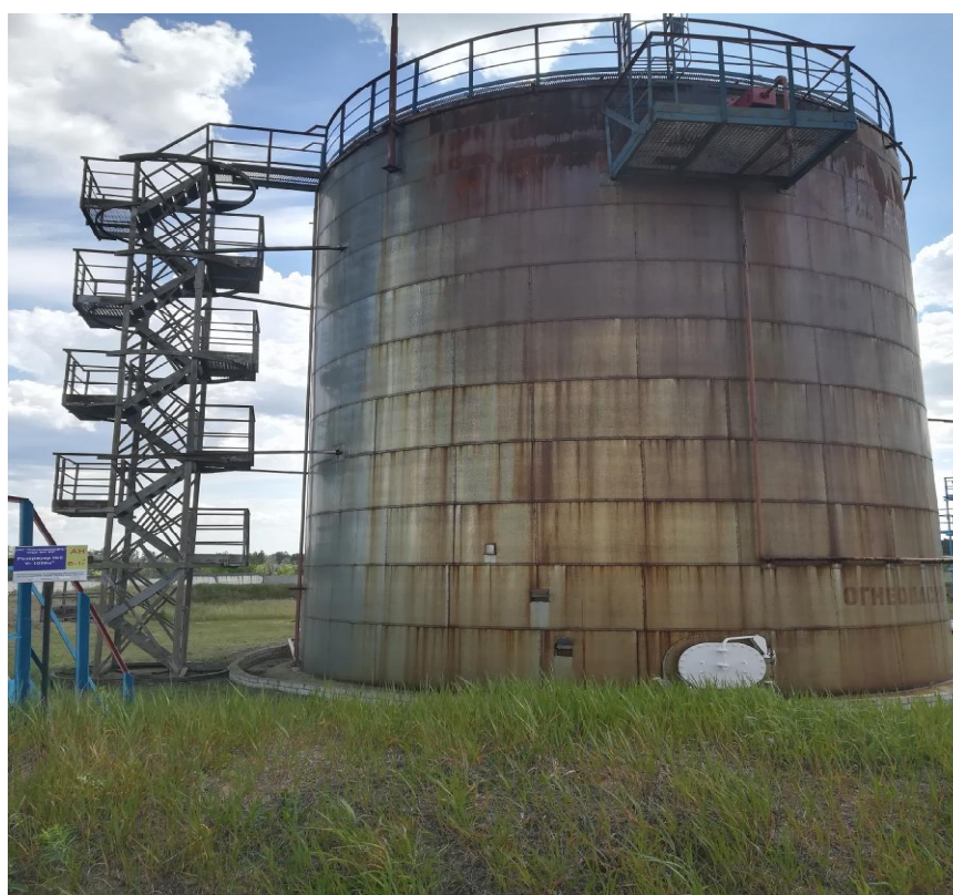
Рисунок 4 - Общий вид резервуара вертикального стального цилиндрического РВС-1000 зав. № 5
