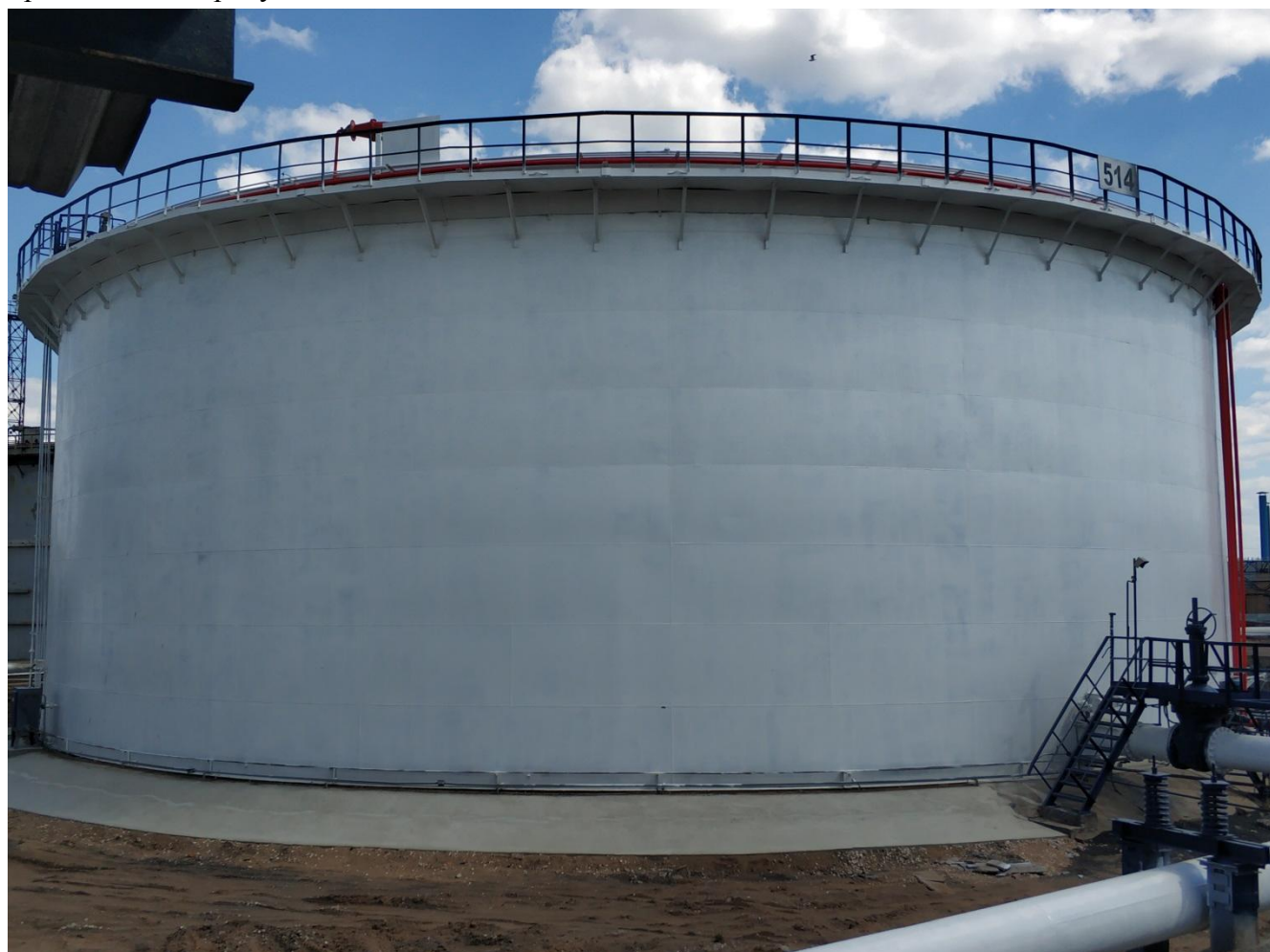
Рисунок 1 - Общий вид резервуара РВСПК-10000
