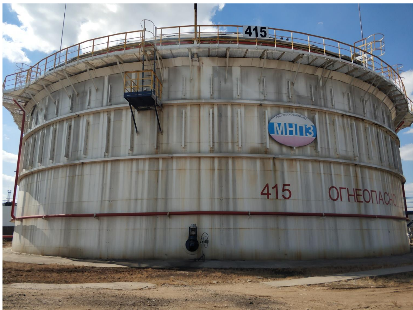
Рисунок 1 - Общий вид резервуара РВСП-10000
