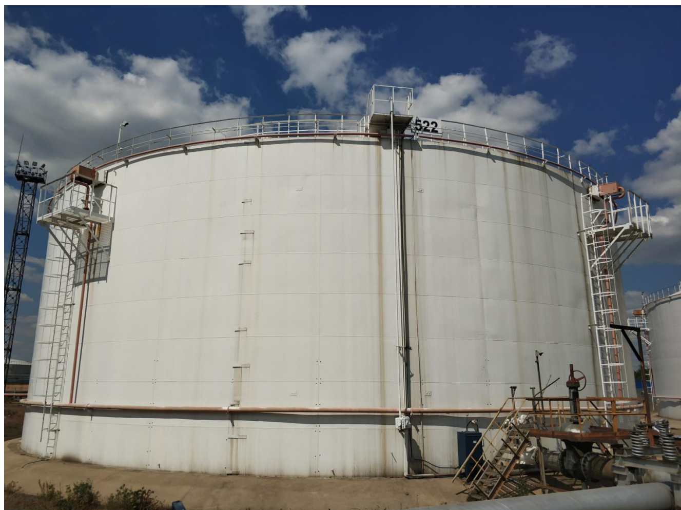
Рисунок 1 - Общий вид резервуара РВС-10000
