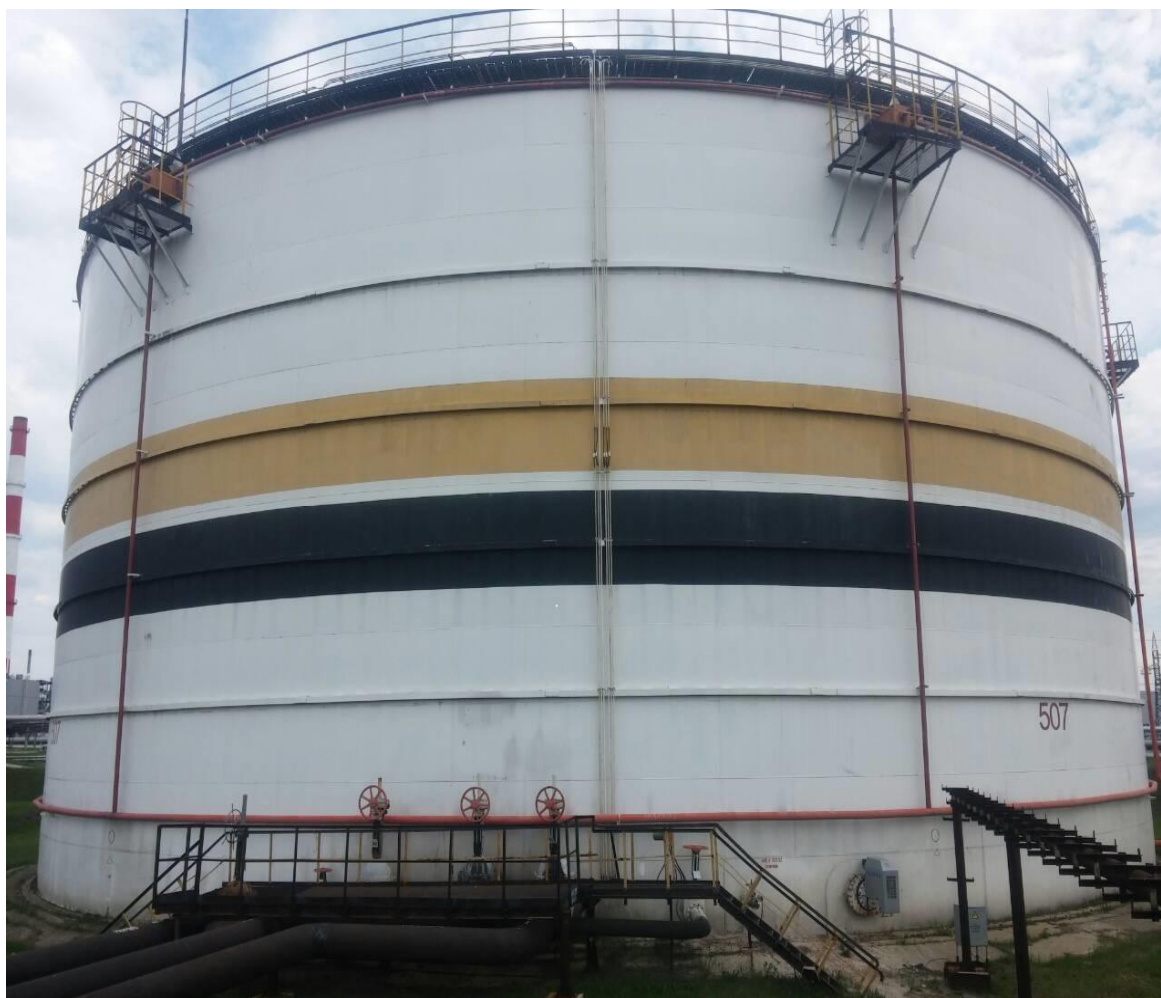
Рисунок 1 - Общий вид резервуара стального вертикального цилиндрического РВС-20000
