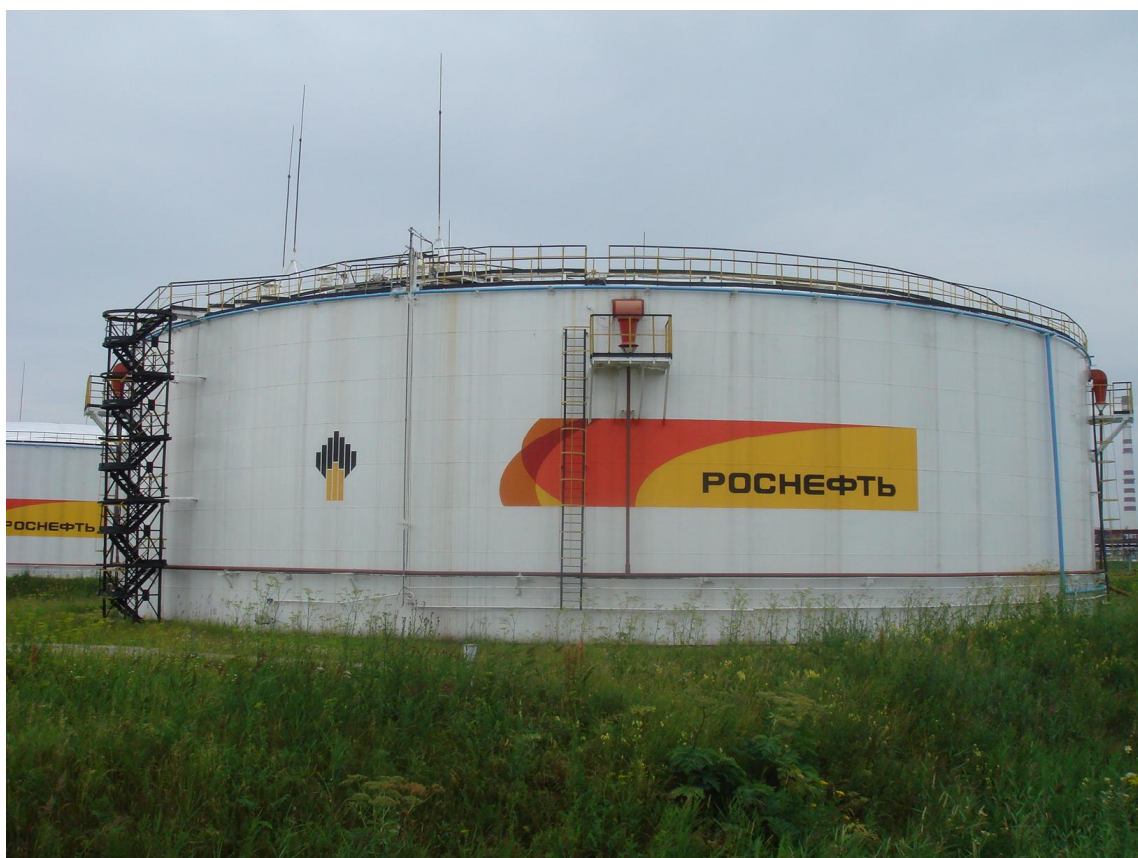
Рисунок 3 - Общий вид резервуара стального вертикального цилиндрического РВС-20000
