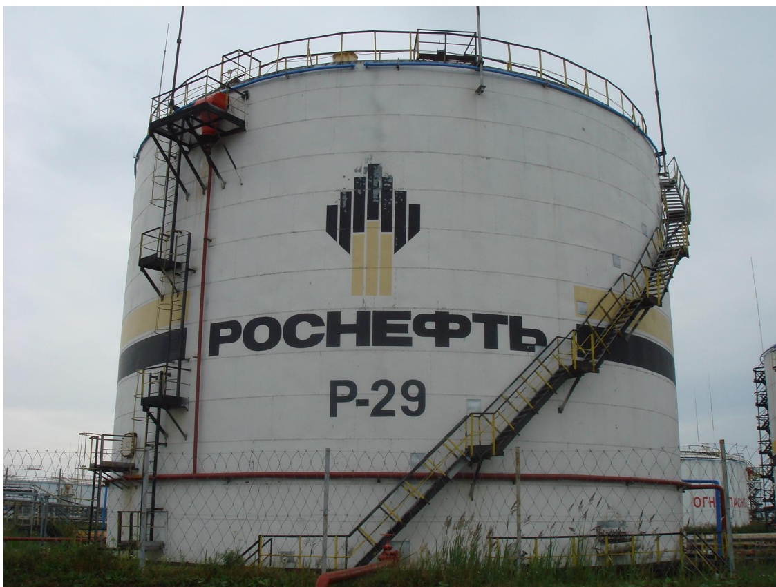
Рисунок 1 - Общий вид резервуара стального вертикального цилиндрического РВС-5000
