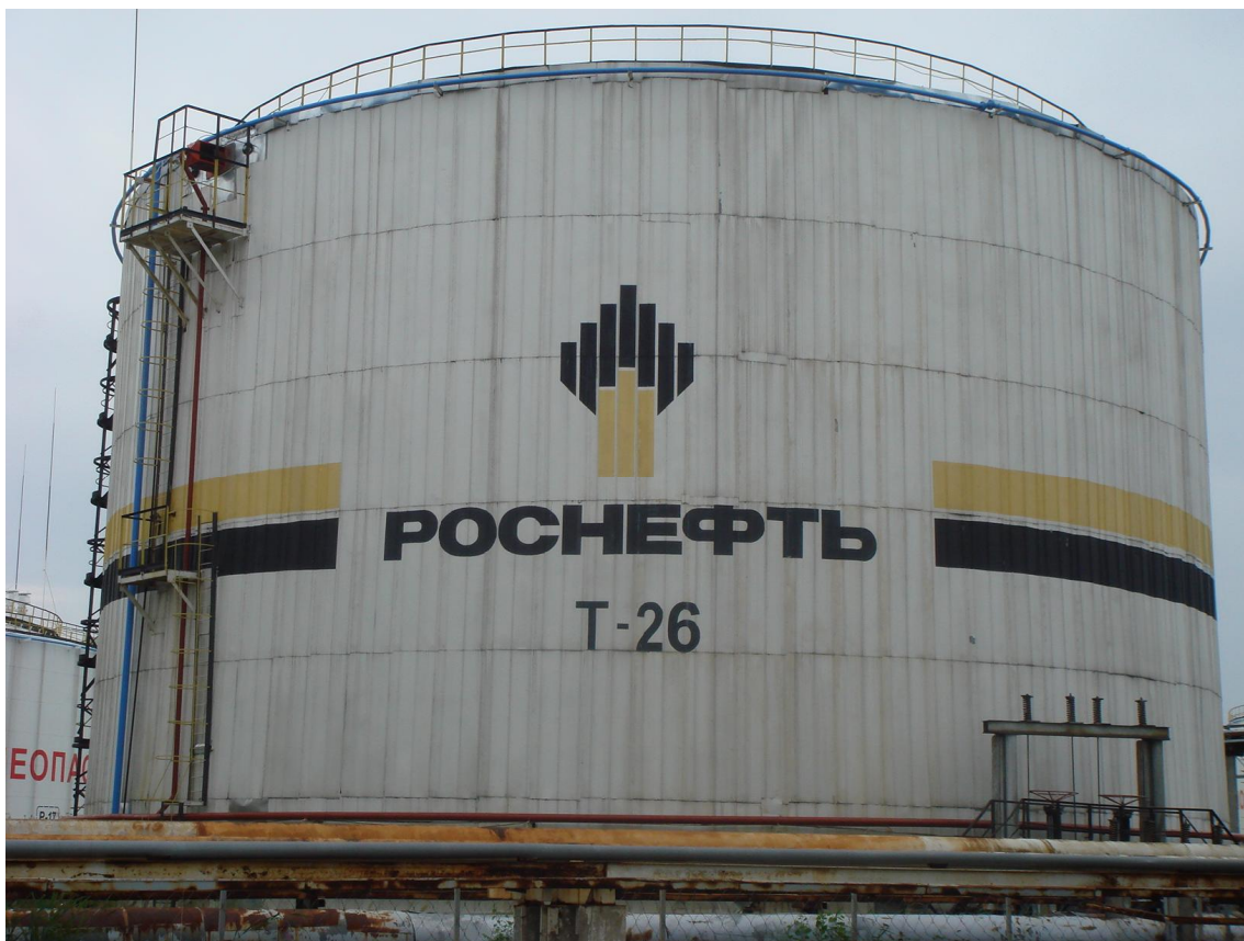
Рисунок 2 - Общий вид резервуара стального вертикального цилиндрического РВС-10000
