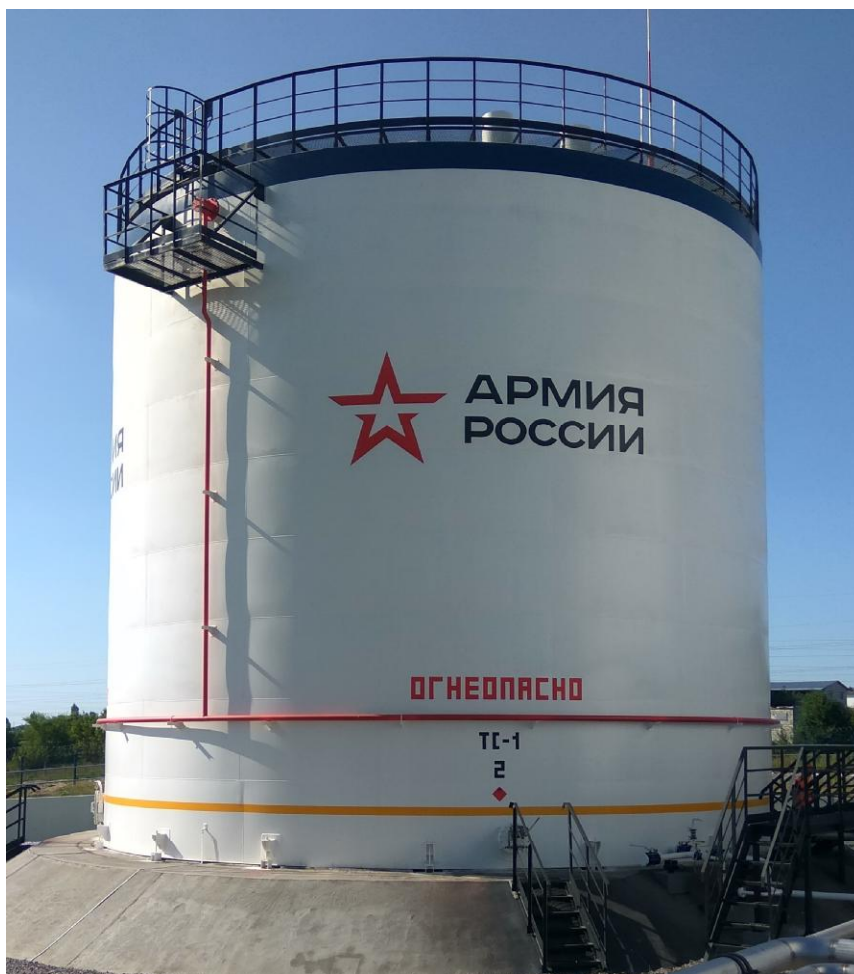
Рисунок 1 - Общий вид резервуара стального вертикального цилиндрического РВС-2400
