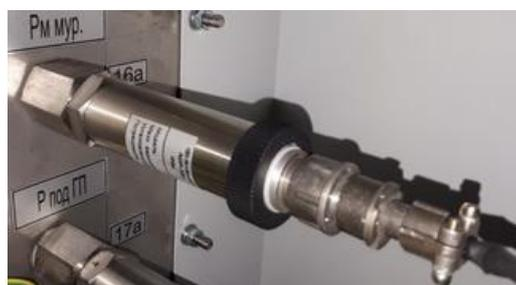
Рисунок 9 – Преобразователь давления
