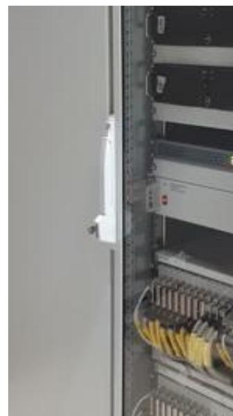
Рисунок 18 – Замок двери стойки приборной АИИС. Вид внешний
