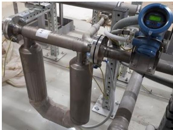
Рисунок 6 – Преобразователь расхода
