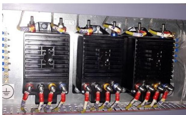
Рисунок 15 – Преобразователи напряжения первичные LEM CV 3-200. Вид внешний
