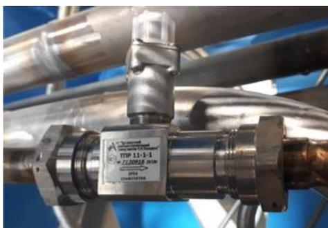
Рисунок 7 – Преобразователь расхода
