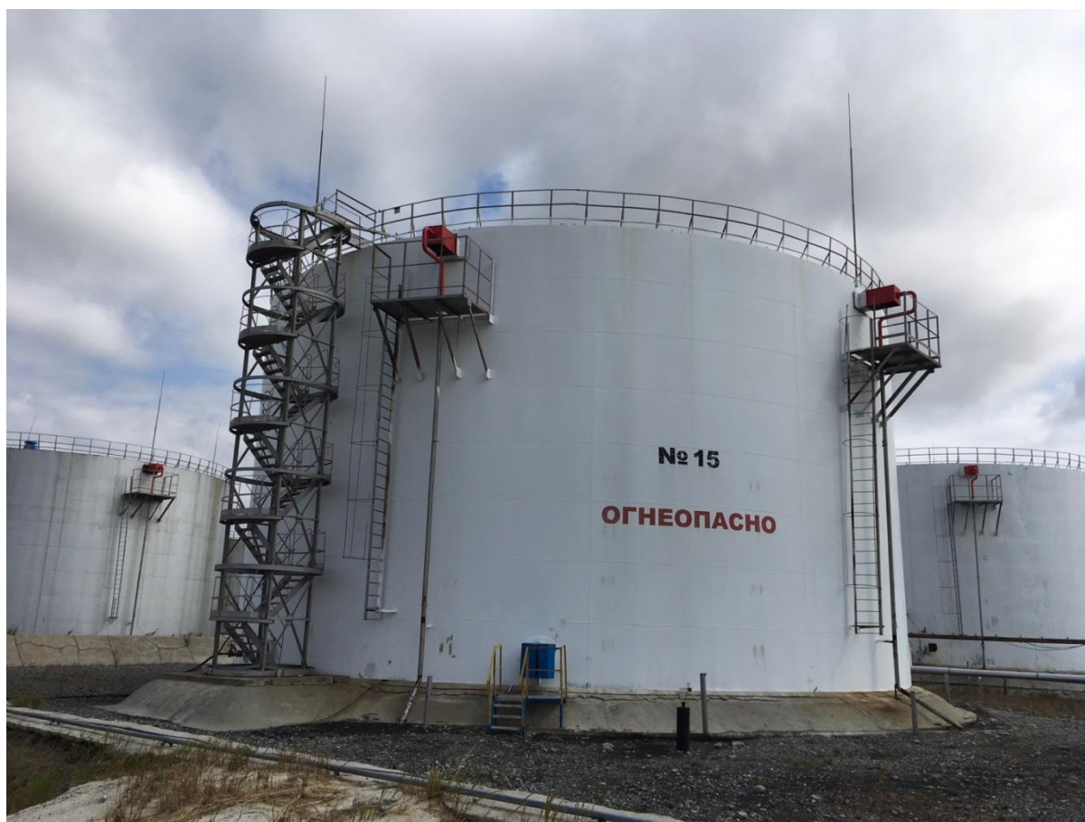
Рисунок 1 - Общий вид резервуара РВС-5000
