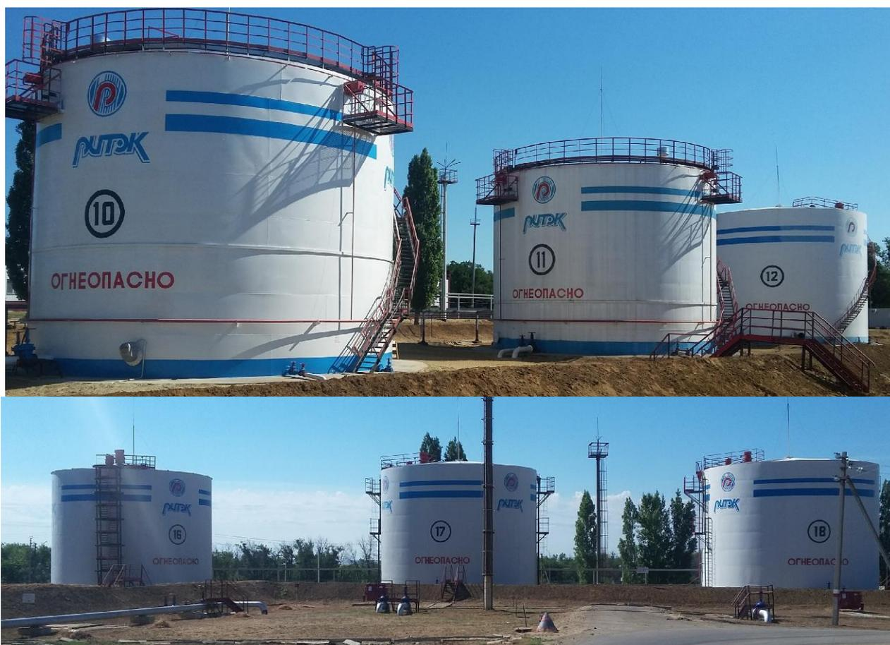
Рисунок 1 - Общий вид резервуаров вертикальных стальных цилиндрических РВС-2000.
