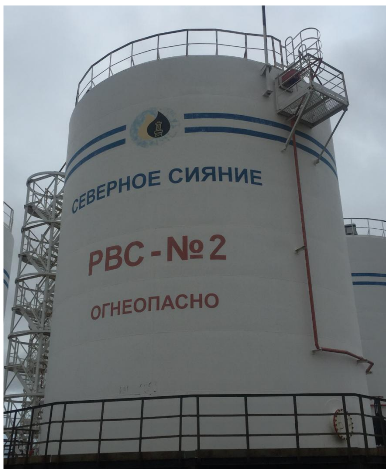
Рисунок 1 - Общий вид резервуара РВС-1000
