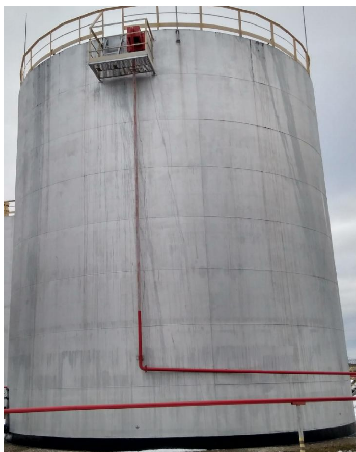
Рисунок 2 - Общий вид резервуара стального вертикального цилиндрического РВС-1000
