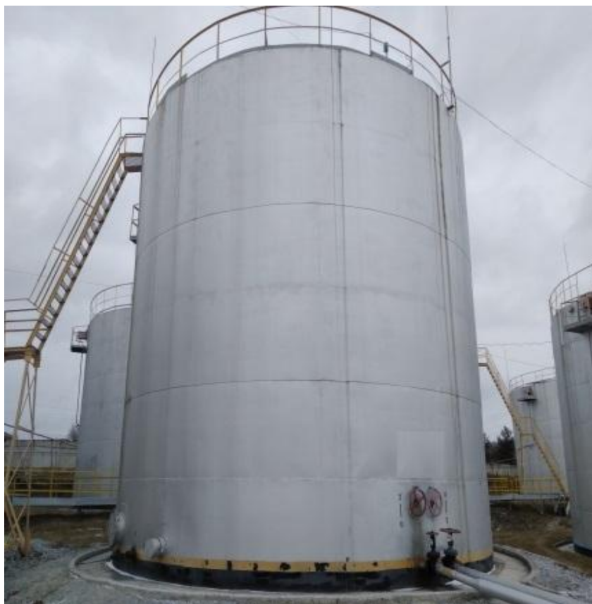
Рисунок 1 - Общий вид резервуара стального вертикального цилиндрического РВС-700
