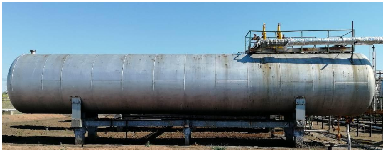
Рисунок 1 - Общий вид резервуара стального горизонтального цилиндрического РГС-200
