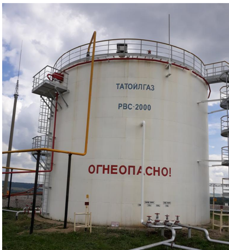
Рисунок 1 - Общий вид резервуара стального вертикального цилиндрического РВС-2000
