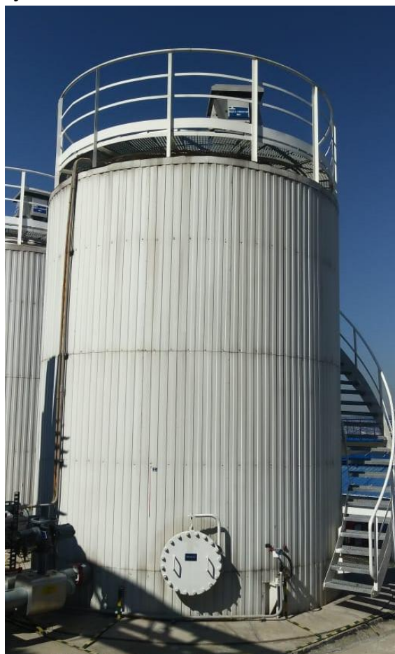
Рисунок 1 - Общий вид резервуара РВС-100
