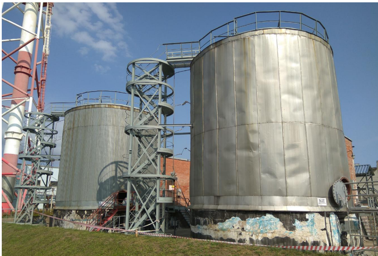
Рисунок 1 - Общий вид резервуаров РВС-300
