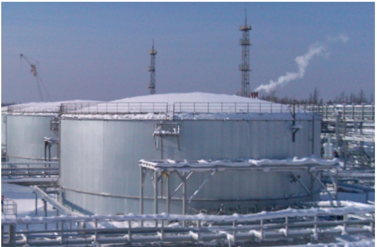
Рисунок 1 - Общий вид резервуара стального вертикального цилиндрического РВС-10000
