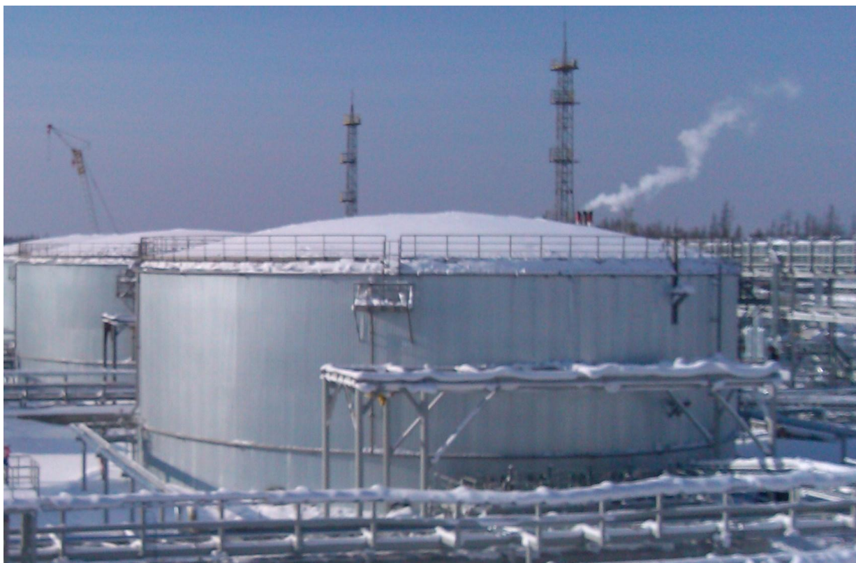
Рисунок 1 - Общий вид резервуара стального вертикального цилиндрического РВС-10000
