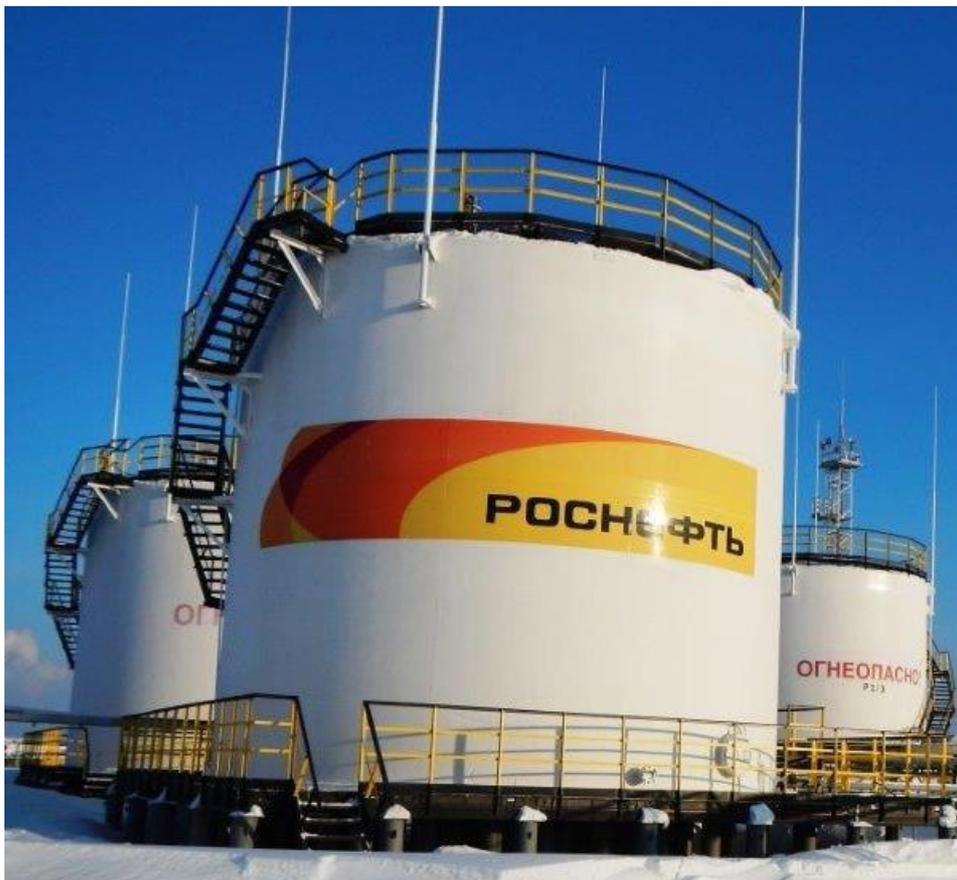
Рисунок 1 - Общий вид резервуара стального вертикального цилиндрического РВС-700
