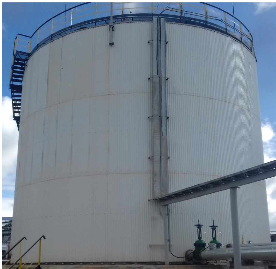
Рисунок 1 - Общий вид резервуара стального вертикального цилиндрического РВС-2000
