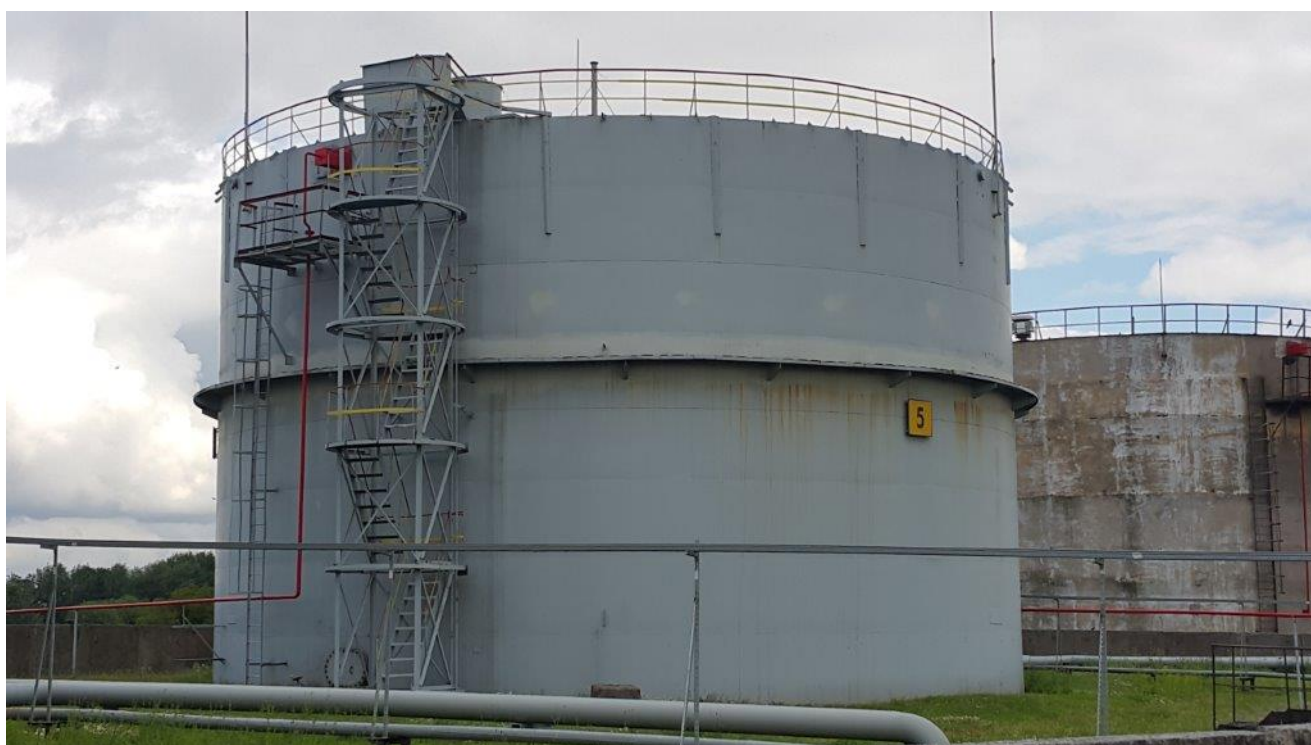
Рисунок 1 - Общий вид резервуара РВС-3000
